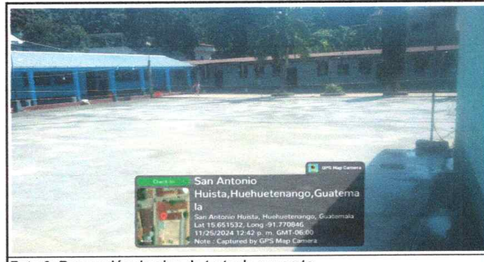
Foto 6: Reparación de piso de torta de concreto
