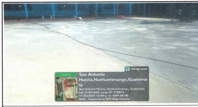
Foto 5: Reparación de piso de torta de concreto
