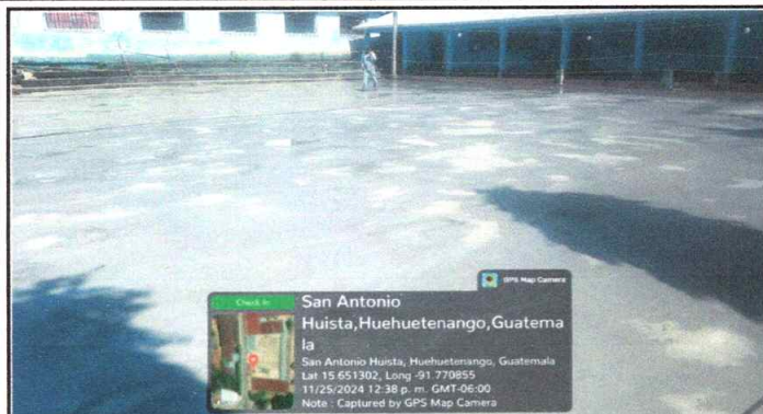
Foto 2: Reparación de piso de torta de concreto
