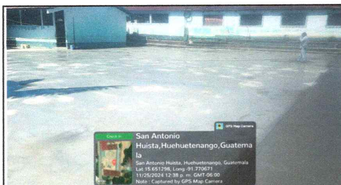
Foto 3: Reparación de piso de torta de concreto
