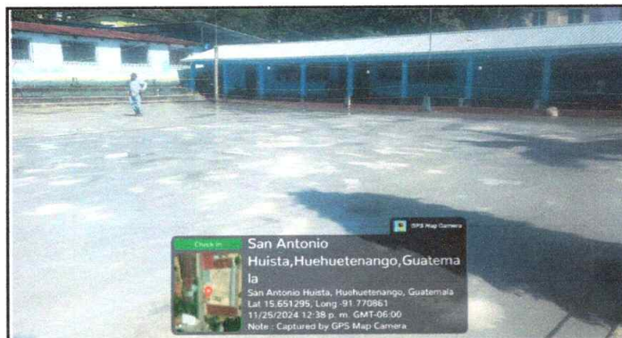
Foto 4: Reparación de piso de torta de concreto
