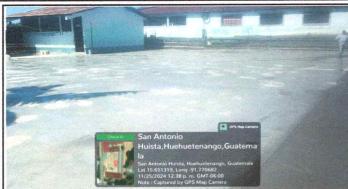
Foto 1: Reparación de piso de torta de concreto
