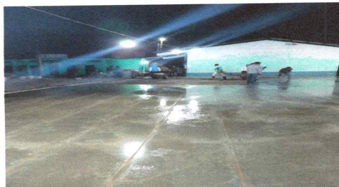
Foto 4: Reparación de piso de torta de concreto
