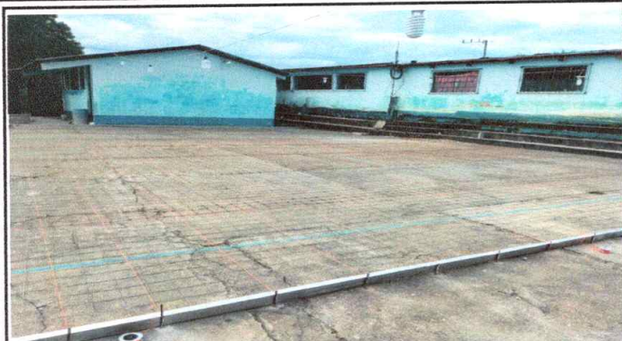
Foto 1: Reparación de piso de torta de concreto
