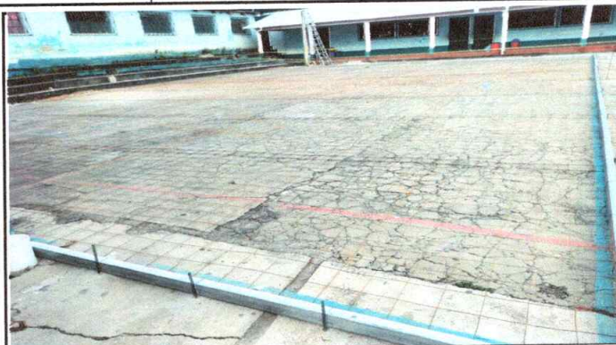
Foto 2: Reparación de piso de torta de concreto
