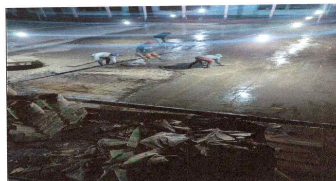
Foto 6: Reparación de piso de torta de concreto
