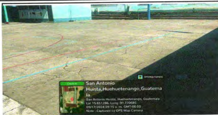
Foto 8: Reparación de piso de torta de concreto
