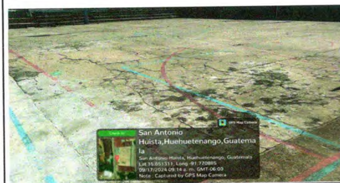
Foto 5: Reparación de piso de torta de concreto
