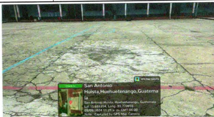
Foto 2: Reparación de piso de torta de concreto
