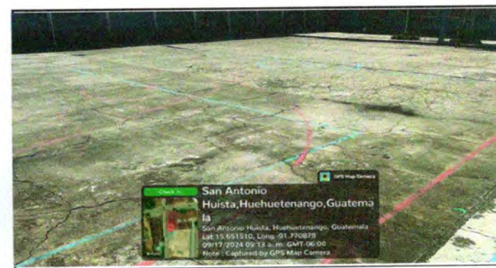
Foto 6: Reparación de piso de torta de concreto
