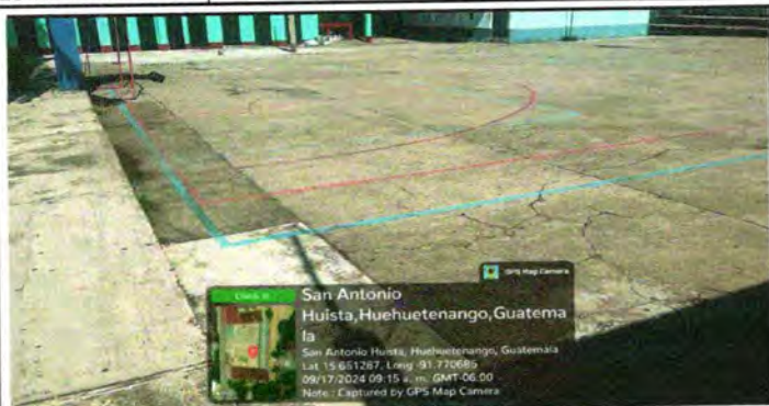
Foto7: Reparación de piso de torta de concreto
