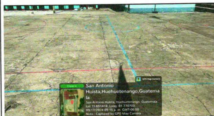
Foto 3: Reparación de piso de torta de concreto
