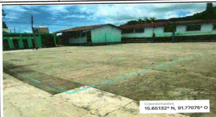
Foto 1: Reparación de piso de torta de concreto
