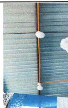
Foto 6: Sustitución de plafoneras
