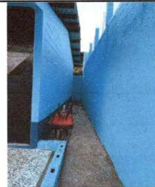
Foto 4: Pintura en muros exteriores e interiores
