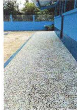
Foto 2: Sustitución de Piso de concreto por piso de granito
