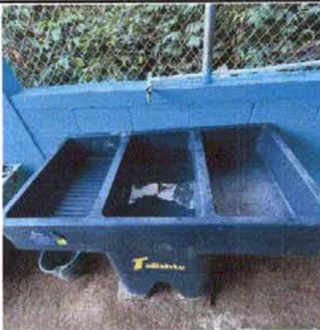
Foto 3: Sustitución de pila de cemento de dos lavaderos, por pila plástica de dos Lavaderos
