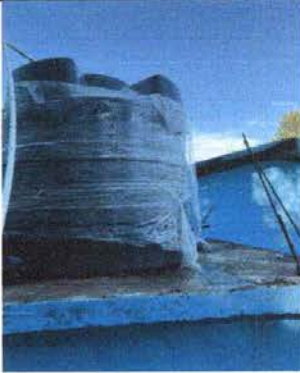
Foto 1: sustitución de deposito de agua 1700
