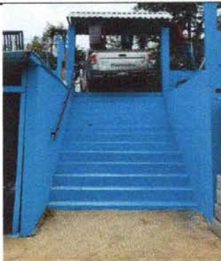
Foto 3: Pintura en muros exteriores e interiores
