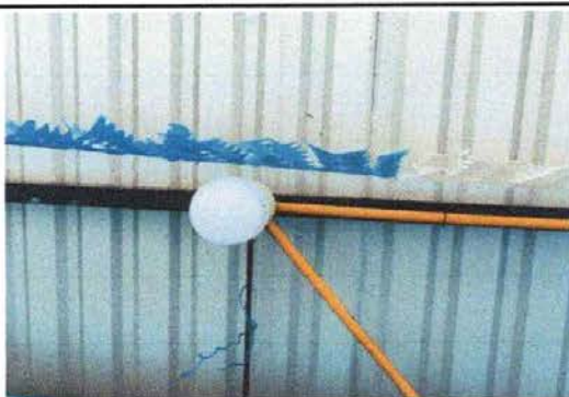
Foto 5: Sustitución de plafoneras
