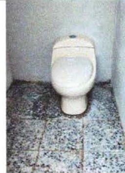
Foto 6: Sustitución de Inodoro
