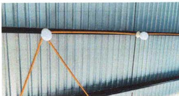
Foto 4: Reparación de lámparas
