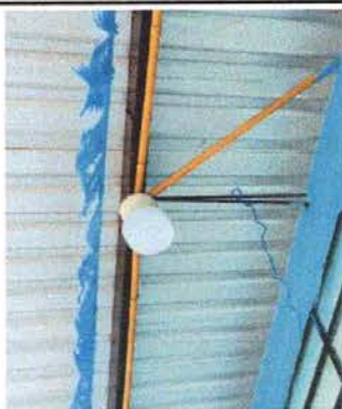
Foto 3: Reparación de lámparas
