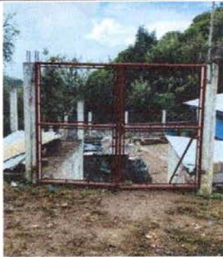
19.5 Fabricación e instalación de portón de metal de ingreso
