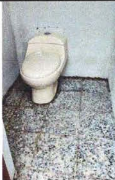
Foto 5: Sustitución de Inodoro
