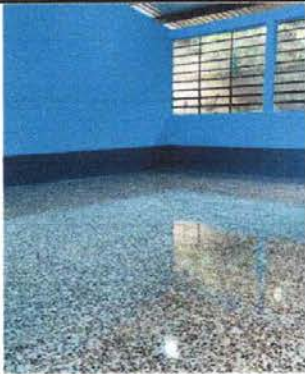
Foto 1: Sustitución de Piso de concreto por piso de granito
