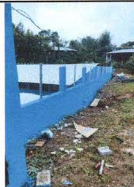
Foto 2: Reparación de muro perimetral de block con tubo hg y malla galvanizada, soleras intermedias y columnas.
