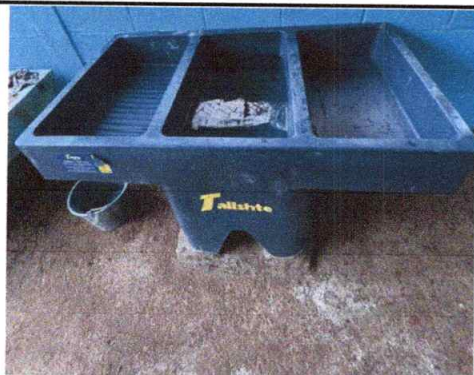
Foto 3: Sustitución de pila de cemento de dos lavaderos, por pila plástica de dos Lavaderos
