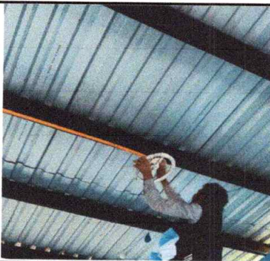
Foto 5: Sustitución de plafoneras
