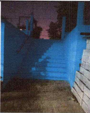
Foto 3: Pintura en muros exteriores e interiores
