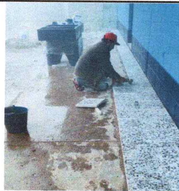
Foto 2: Sustitución de Piso de concreto por piso de granito
