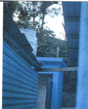
Foto 2: sustitución de depósito de agua 1700
