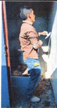
Foto 5: Sustitución de inodoro
