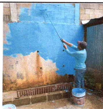
Foto 4: Pintura en muros exteriores e interiores
