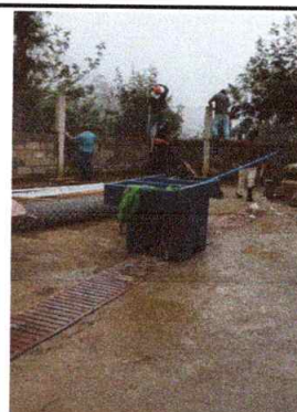
Foto 4: Sustitución de pila de cemento de dos lavaderos, por pila plástica de dos Lavaderos
