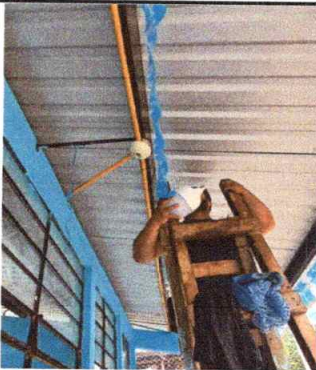
Foto 3: Reparación de lámparas
