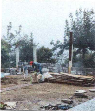
Foto 1: Reparación de muro perimetral de block con tubo hg y malla galvanizada, soleras intermedias y columnas.
