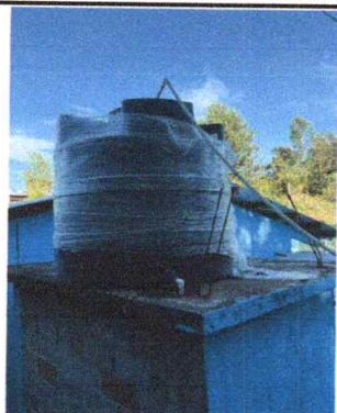
Foto 1: sustitución de depósito de agua 1700
