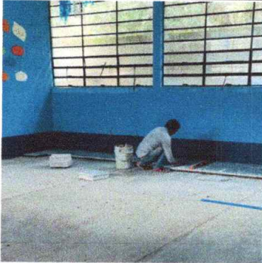
Foto 1: Sustitución de Piso de concreto por piso de granito
