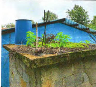
Foto1: sustitución de deposito de agua 1700
