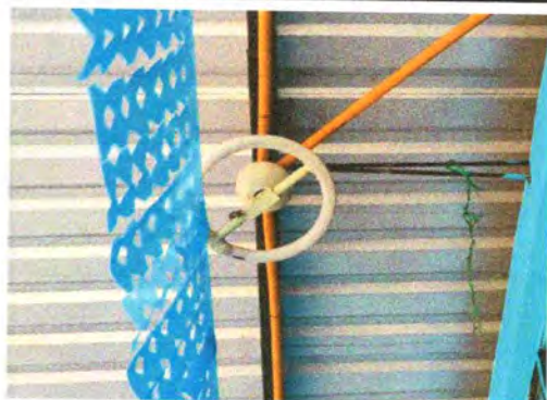
Foto 3: Reparación de lámparas
