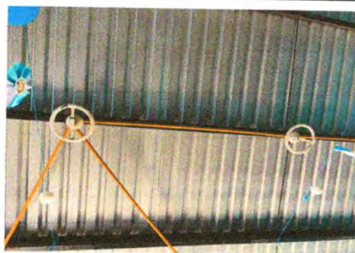
Foto 4: Reparación de lámparas
