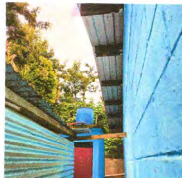
Foto 2: sustitución de deposito de agua 1700
