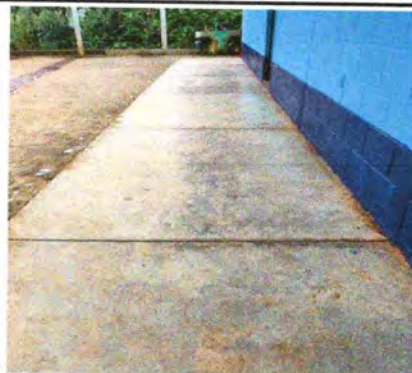
Foto 2: Sustrucción de Piso de concreto por piso de granito
