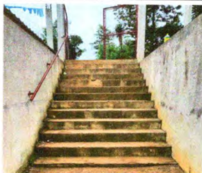
Foto 3: Pintura en muros exteriores e interiores
