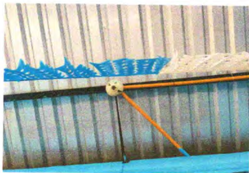
Foto 5: Sustitución de plafoneras
