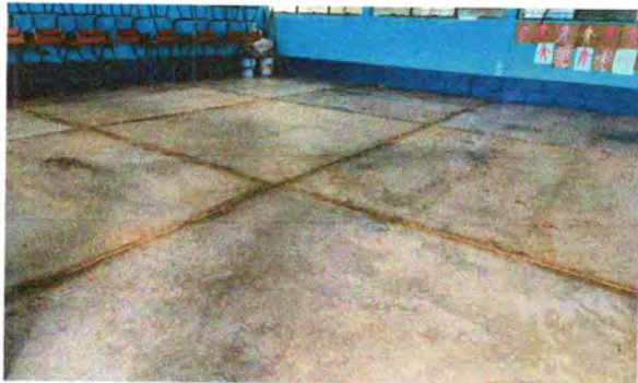
Foto 1: Sustrucción de Piso de concreto por piso de granito
