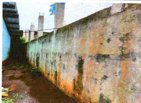
Foto 4: Pintura en muros exteriores e interiores
