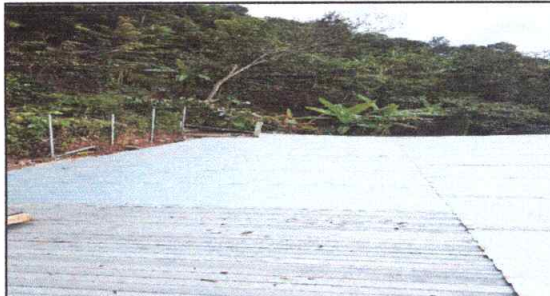
Foto 2: SUSTITUCIÓN LÁMINA, POR LÁMINA TROQUELADA ALUZINC CALIBRE 26.
