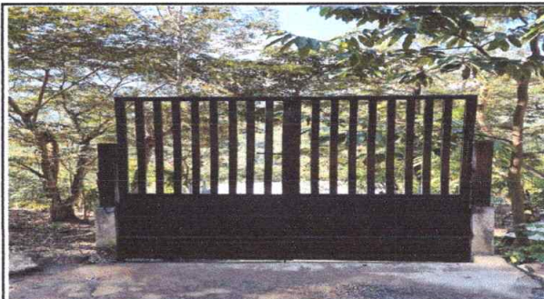
FOTO 10: SUSTITUCIÓN DE PORTÓN DE METAL.
