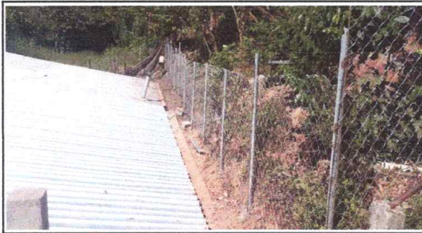
FOTO 12: REPARACION DE TUBO HG Y MALLA GALVANIZADA.
