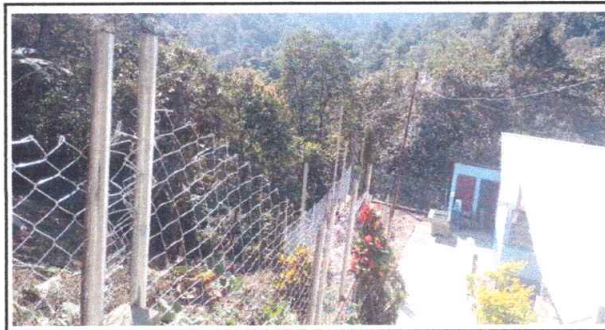
FOTO 11: REPARACIÓN DE TUBO HG Y MALLA GALVANIZADA.
