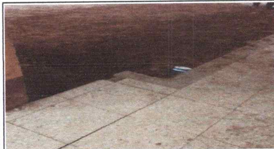
FOTO 3: SUSTITUCIÓN DE PISO DE TORTA DE CONCRETO POR, TORTA DE CEMENTO.
