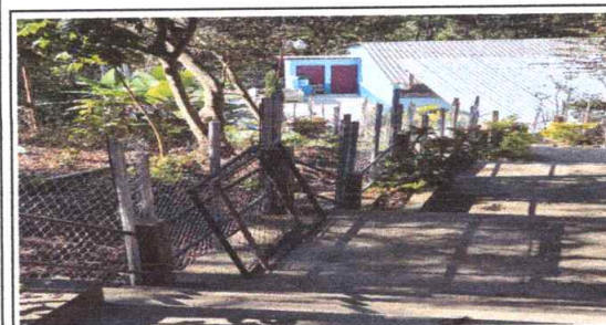
FOTO 5: SUSTITUCIÓN DE PORTÓN DE METAL.
