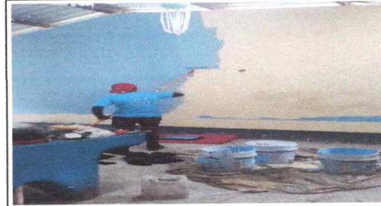
FOTO 4: PINTURA EN MUROS EXTERIORES E INTERIORES
