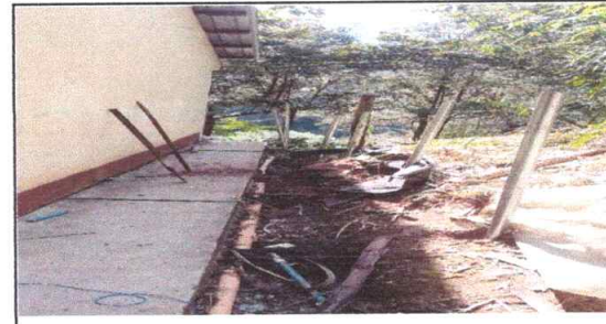
FOTO 6: REPARACION DE TUBO HG Y MALLA GALVANIZADA.
