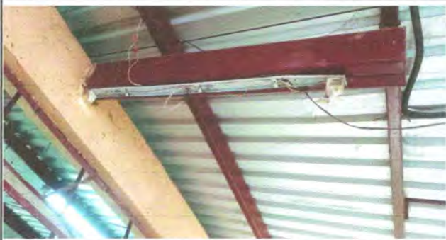
FOTO 1: RENGLÓN NÚMERO 17. REPARACIÓN DE SISTEMA ELÉCTRICO.
