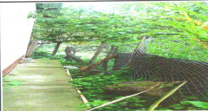
FOTO 2: RENGLÓN NÚMERO 15. MUROS PERIMETRALES. 15.3 REPARACIÓN DE TUBO HG Y MALLA GALVANIZADA.
