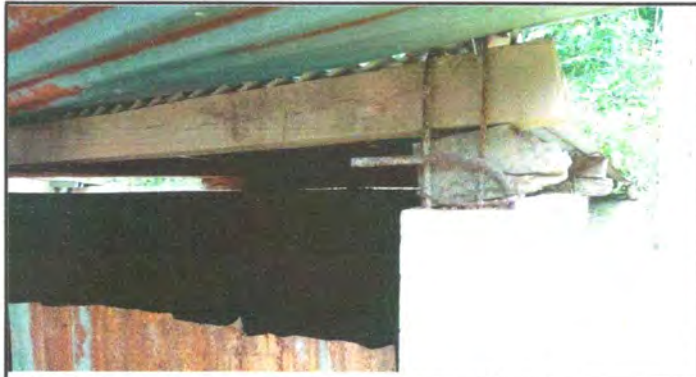
FOTO 2: RENGLÓN NÚMERO 2. ESTRUCTURA DE TECHO. 2.2 SUSTITUCIÓN DE ESTRUCTURA DE SOPORTE DE MADERA POR, METAL.
