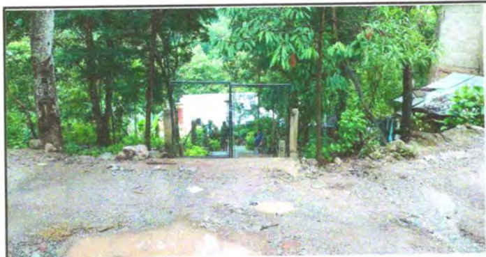
FOTO 1: RENGLÓN NÚMERO 4. PUERTAS DE METAL. 4.5 SUSTITUCIÓN DE PORTÓN DE METAL.
