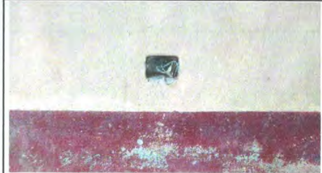
FOTO 2: RENGLÓN NÚMERO 17. REPARACIÓN DE SISTEMA ELÉCTRICO.
