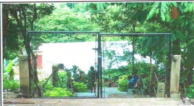
FOTO 2: RENGLÓN NÚMERO 4. PUERTAS DE METAL. 4.5 SUSTITUCIÓN DE PORTÓN DE METAL.
