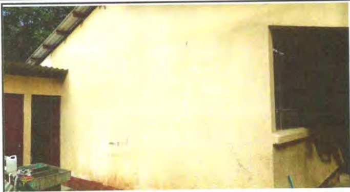
FOTO 1: RENGLÓN NÚMERO 9. PINTURA EN MUROS EXTERIORES E INTERIORES. 9.1 PINTURA EN MUROS EXTERIORES E INTERIORES
