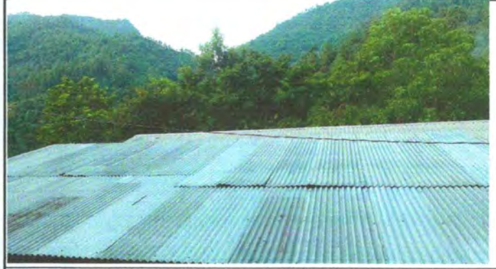
Foto 2: RENGLÓN NÚMERO 1. 1.1 SUSTITUCIÓN LÁMINA, POR LÁMINA TROQUELADA ALUZINC CALIBRE 26.
