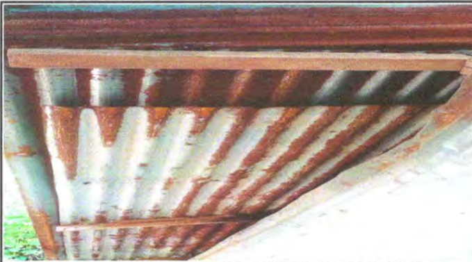
FOTO 1: RENGLÓN NÚMERO 2. ESTRUCTURA DE TECHO 2.2 SUSTITUCIÓN DE ESTRUCTURA DE SOPORTE DE MADERA POR, METAL.
