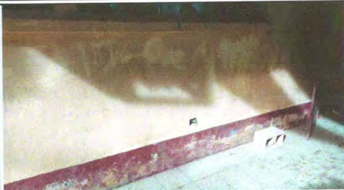
FOTO 2: RENGLÓN NÚMERO 9. PINTURA EN MUROS EXTERIORES E INTERIORES. 9.1 PINTURA EN MUROS EXTERIORES E INTERIORES
