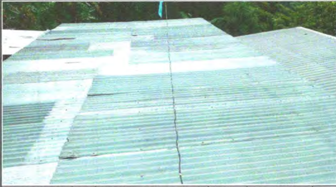
Foto 1: RENGLÓN NÚMERO 1. 1.1 SUSTITUCIÓN DE LÁMINA, POR LÁMINA TROQUELADA ALUZINC CALIBRE 26.
