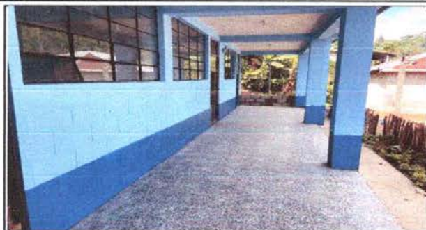
Foto1: Sustrucción de piso de granito
