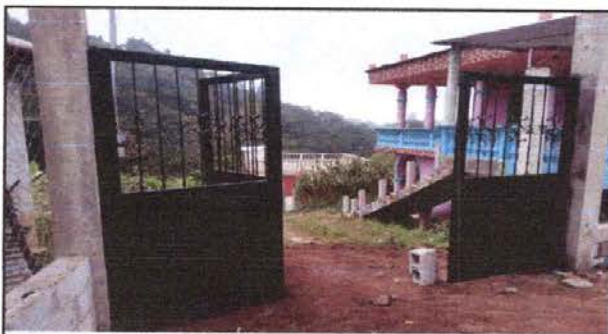
Foto 9: Sustitución de portón de metal
