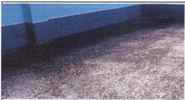
Foto 3: Sustrucción de piso de granito
