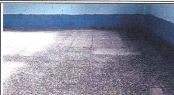
Foto 2: Sustrucción de piso de granito
