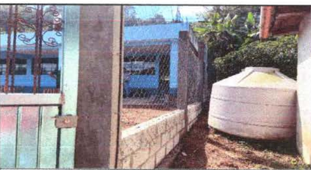
Foto 6: Reparación de muro perimetral de block con tubo hg y maya galvanizada, soleras intermedias y columnas
