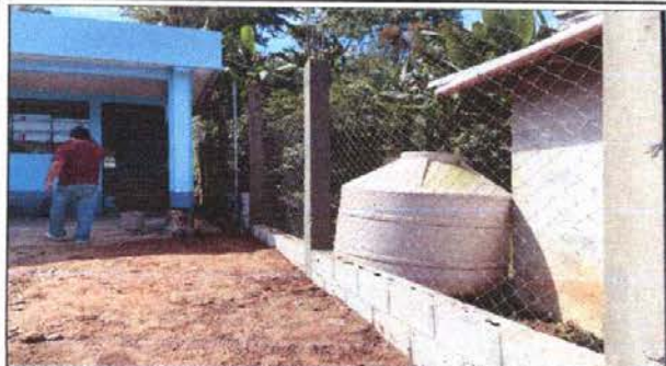
Foto 7: Reparación de muro perimetral de block con tubo hg y maya galvanizada, soleras intermedias y columnas
