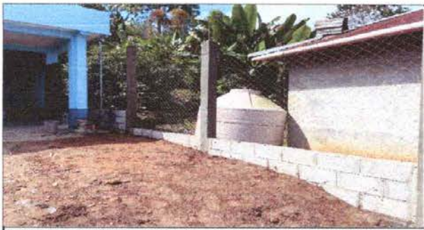
Foto 5: Reparación de muro perimetral de block con tubo hg y maya galvanizada, soleras intermedias y columnas
