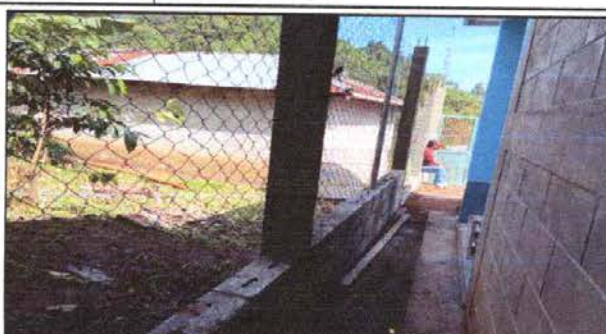
Foto 8: Reparación de muro perimetral de block con tubo hg y maya galvanizada, soleras intermedias y columnas
