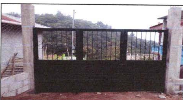
Foto 10: Sustitución de portón de metal
