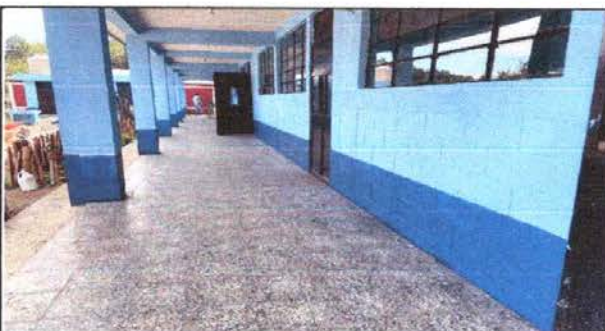
Foto 4: Sustrucción de piso de granito
