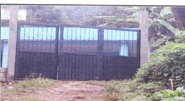
Foto 12: Sustitución de portón de metal
