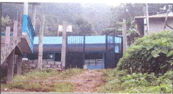
Foto 11: Sustitución de portón de metal
