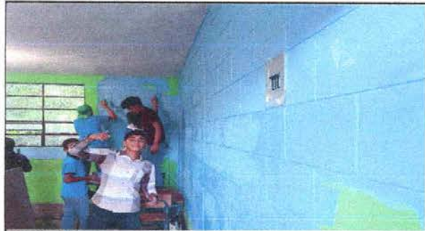
Foto13: Pintura en exteriores e interiores
