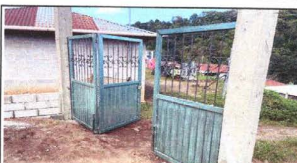
Foto 10: Sustitución de portón de metal
