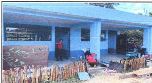
Foto 15: Pintura en exteriores e interiores
