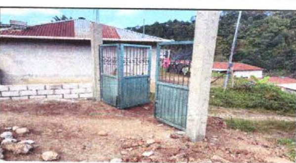
Foto 12: Sustitución de portón de metal
