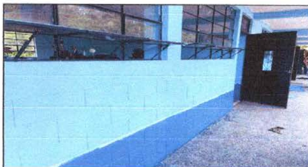
Foto 16: Pintura en exteriores e interiores
