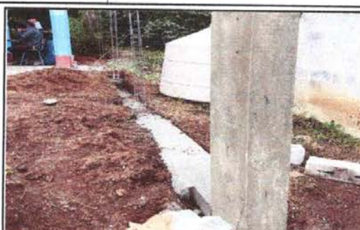
Foto 8: Reparación de muro perimetral de block con tubo hg y maya galvanizada, soleras intermedias y columnas
