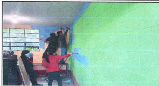
Foto 14: Pintura en exteriores e interiores
