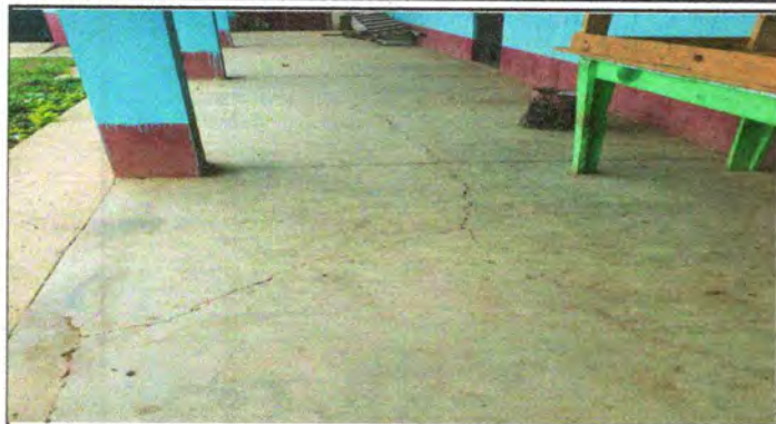
Foto 1: COLOCAR PISO DE GRANITO
