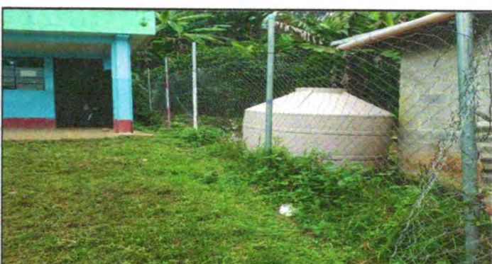
Foto 6: CAMBIAR POR MURO PERIMETRAL
