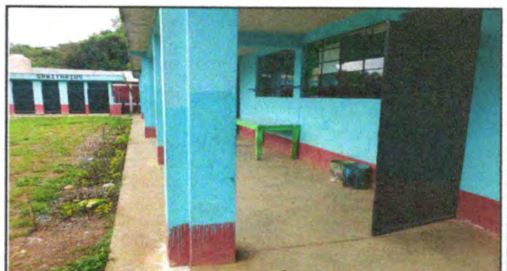
Foto 16: PINTAR PARED EXTERIOR
