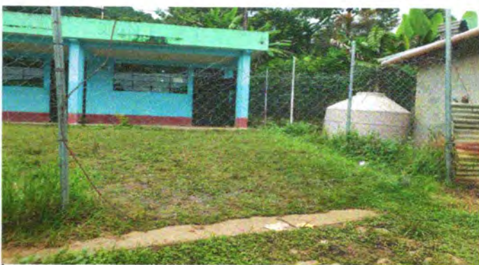
Foto 10: CAMBIAR POR PORTON DE METAL
