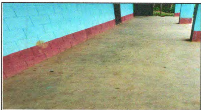
Foto 3: COLOCAR PISO DE GRANITO
