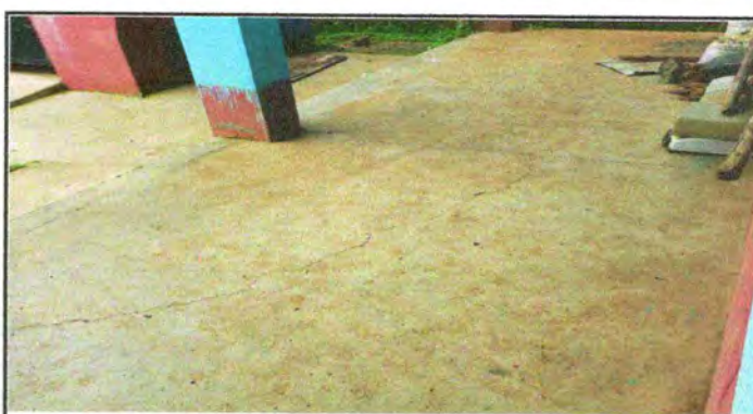
Foto 4: COLOCAR PISO DE GRANITO
