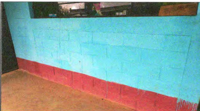
Foto 15: PINTAR PARED EXTERIOR
