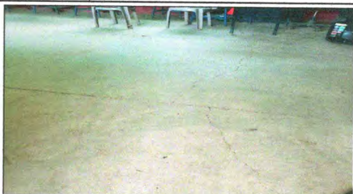
Foto 2: COLOCAR PISO DE GRANITO
