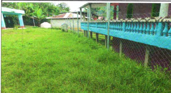
Foto 7: CAMBIAR POR MURO PERIMETRAL
