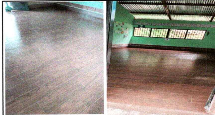
Foto 4: Sustrucción de piso de concreto por cerámico
