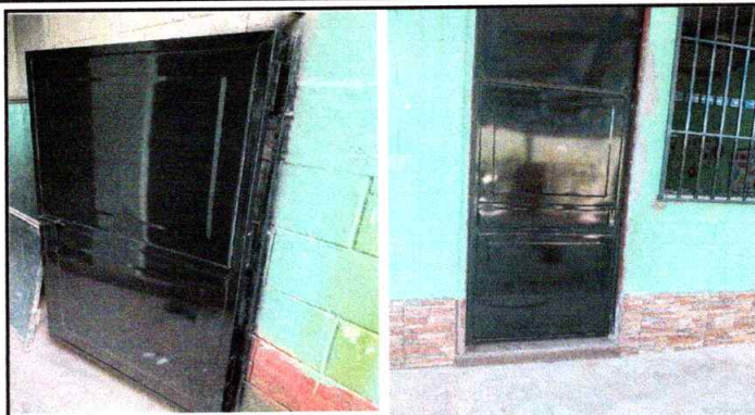
Foto 2: Sustrucción de puerta de metal
