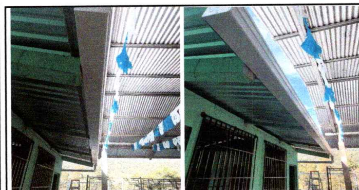
Foto 5: Sustrucción de canal de pvc
