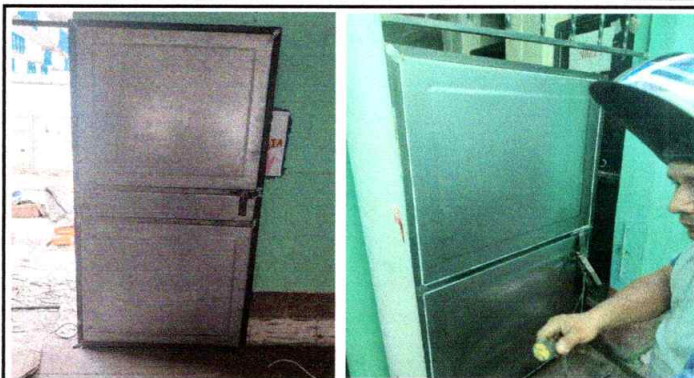
Foto 2: Sustitución de puerta de metal
