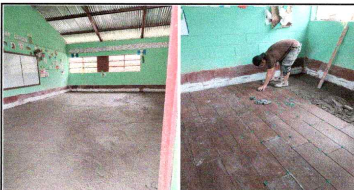
Foto 4: Sustitución de piso de concreto por cerámico
