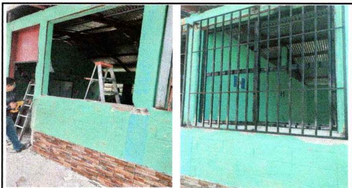
Foto 3: Sustitución de estructura de metal de ventana
