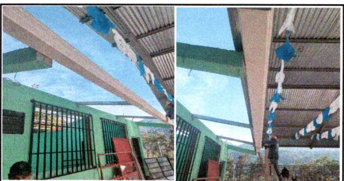
Foto 5: Sustitución de canal de pvc
