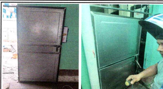
Foto 2: Sustitución de puerta de metal
