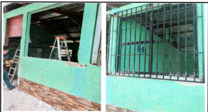
Foto 3: Sustitución de estructura de metal de ventana
