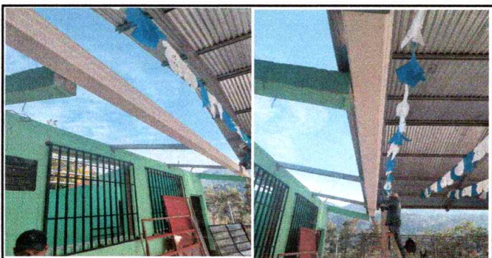
Foto 5: Sustitución de canal de pvc
