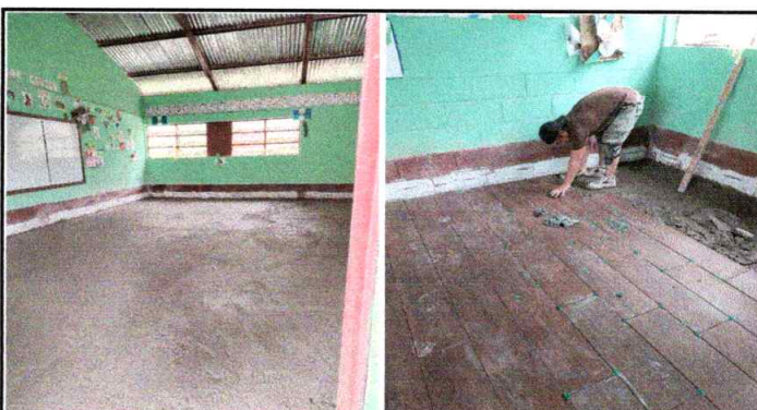
Foto 4: Sustitución de piso de concreto por cerámico
