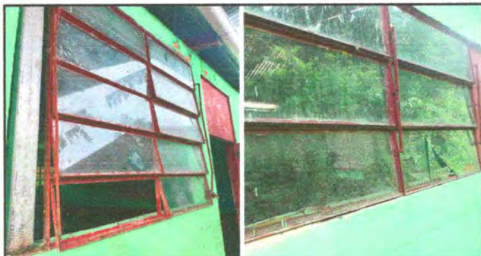
Foto 3: Sustitución de estructura de metal de ventana
