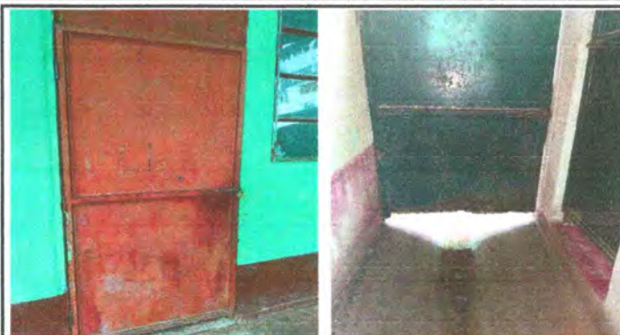
Foto 2: Sustitución de puera de metal
