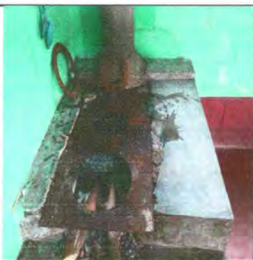
Foto 7: Sustitución de estufa rural (completa) incluye chimenea y plancha de metal
