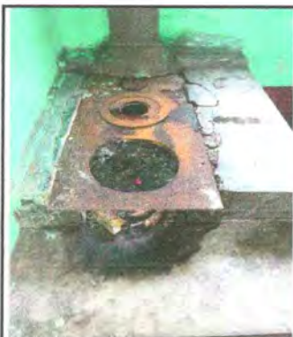
Foto 7: Sustitución de estufa rural (completa) incluye chimenea y plancha de metal
