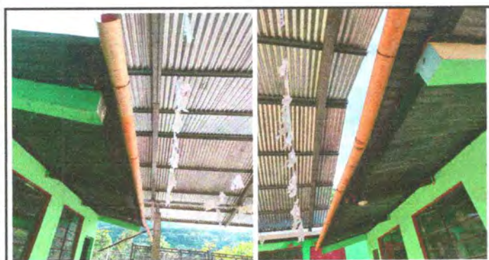
Foto 5: Sustitución de canal de pvc
