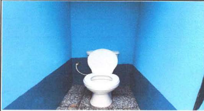
Foto 7: Sustrucción de inodoro
