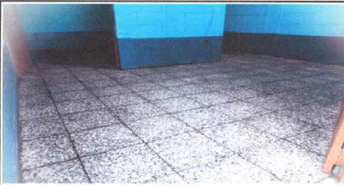
Foto 9: Sustrucción de piso de torta de concreto por piso granito
