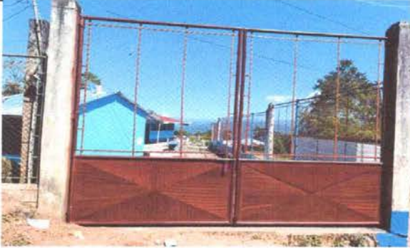
Foto13: Mantenimiento a portones de metal
