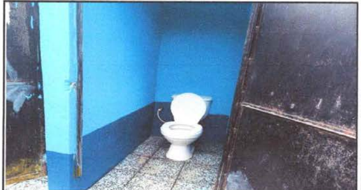
Foto 8: Sustrucción de inodoro
