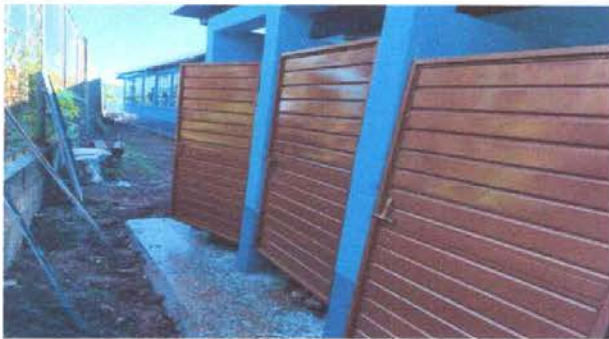
Foto 21: Sustitución de puerta en servicios sanitarios
