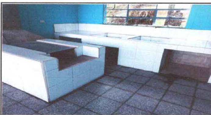
Foto 4: Instalación de azulejo en estufa rural
