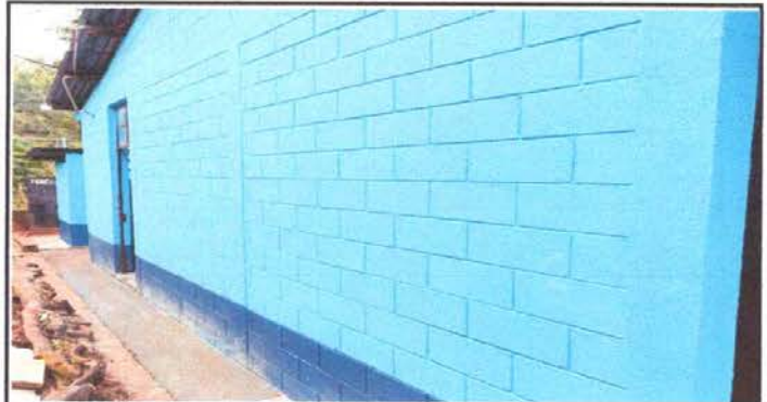
Foto 16: Pintura en muros exteriores e interiores
