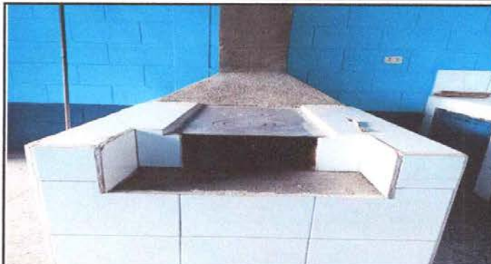
Foto 2: Sustrucción de estufa rural (Completa) incluye chimenea y plancha de metal
