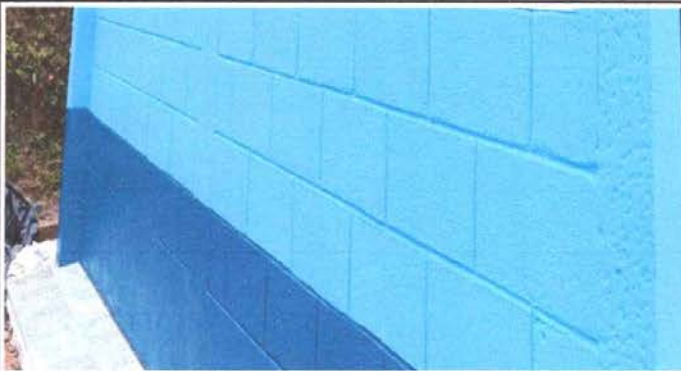
Foto 15: Pintura en muros exteriores e interiores
