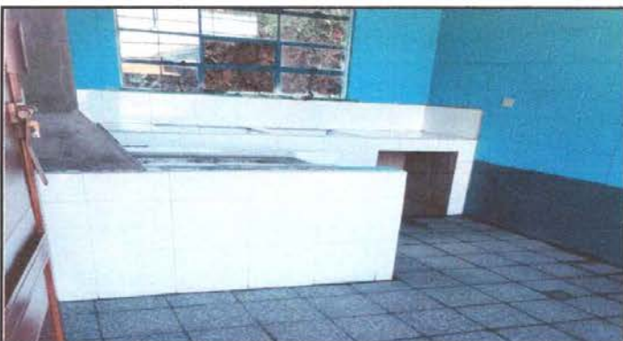
Foto 3: Instalación de azulejo en estufa rural
