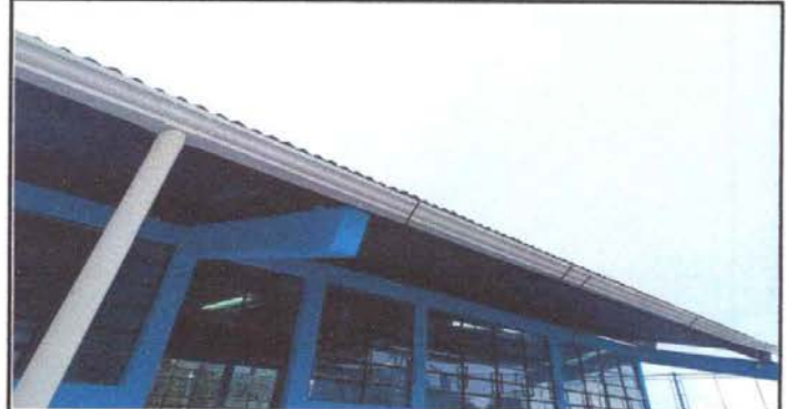
Foto 20: Sustitución de canal de pvc
