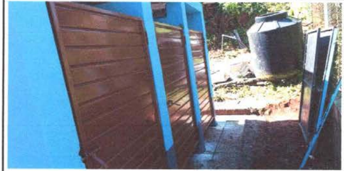
Foto 22: Sustitución de puerta en servicios sanitarios
