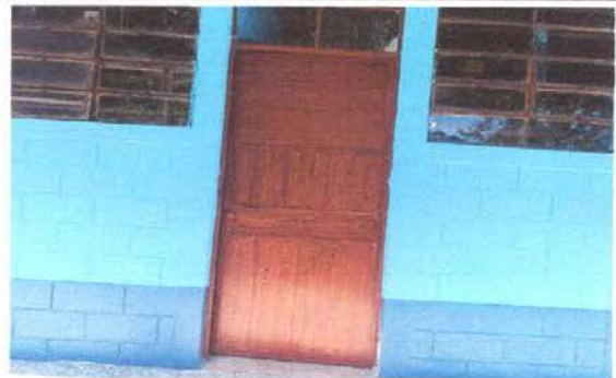
Foto 12: Mantenimiento a estructura (lijado, cambio de tubo, cepillado, sujeciones, aplicación de pintura)
