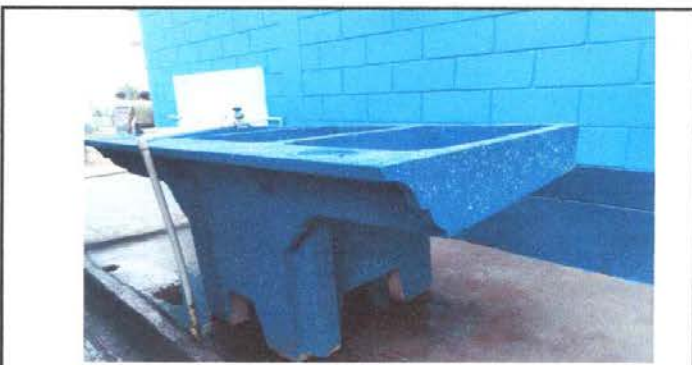
Foto 6: Sustrucción de pila de cemento de 2 lavaderos
