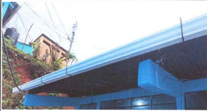
Foto 19: Sustitución de canal de pvc
