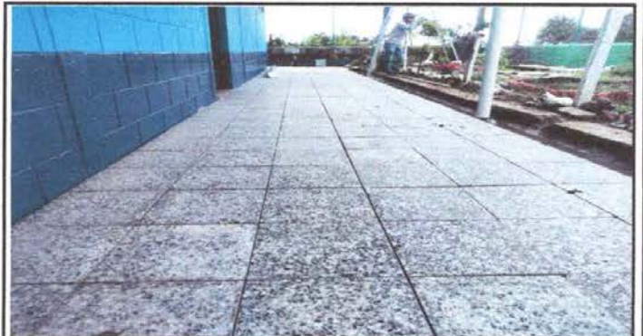
Foto 10: Sustrucción de piso de torta de concreto por piso granito
