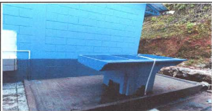
Foto 5: Sustrucción de pila de cemento de 2 lavaderos
