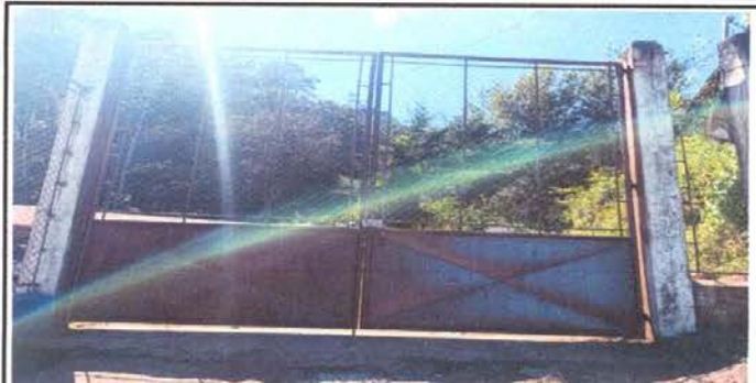
Foto 14: Mantenimiento a portones de metal
