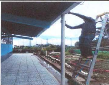
Foto 17: Sustitución de bajada de agua pluvial, tubo PVC 3"
