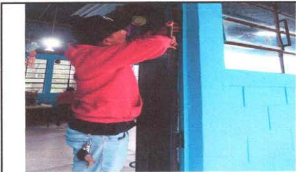
Foto 11: Mantenimiento a estructura (lijado, cambio de tubo, cepillado, sujeciones, aplicación de pintura)
