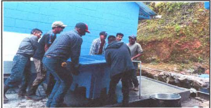
Foto 6: Sustitución de pila de cemento de 2 lavaderos
