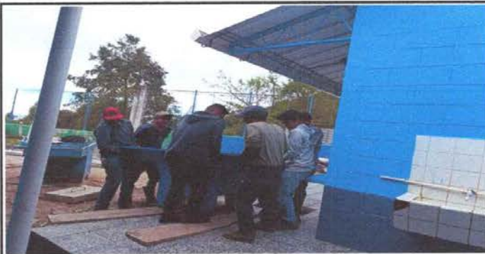
Foto 5: Sustitución de pila de cemento de 2 lavaderos
