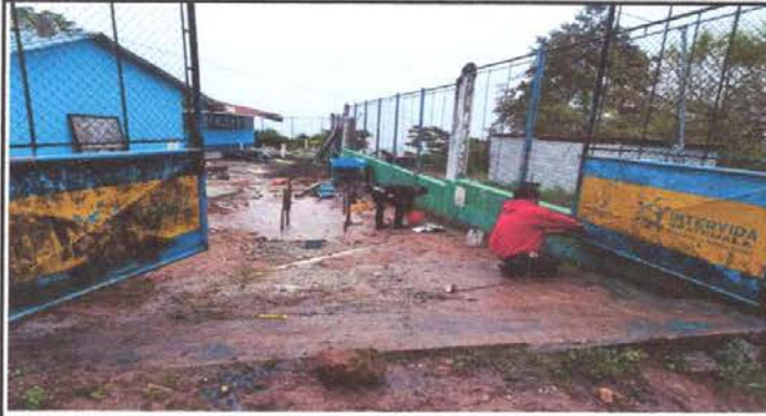
Foto13: Mantenimiento a portones de metal
