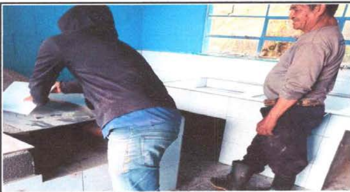
Foto 3: Instalación de azulejo en estufa rural
