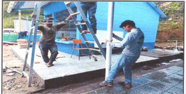
Foto 18: Sustitución de bajada de agua pluvial, tubo PVC 3"
