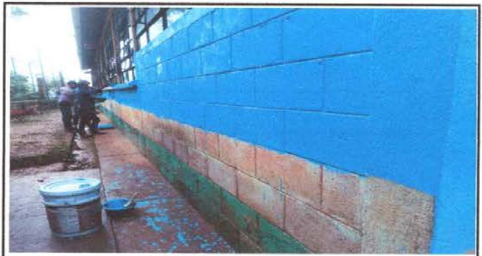
Foto 16: Pintura en muros exteriores e interiores
