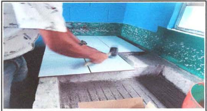
Foto 4: Instalación de azulejo en estufa rural
