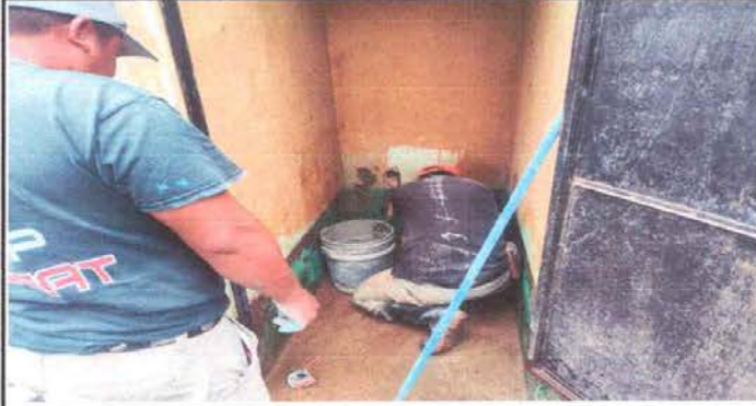
Foto7: Sustitución de inodoro
