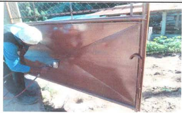
Foto 14: Mantenimiento a portones de metal
