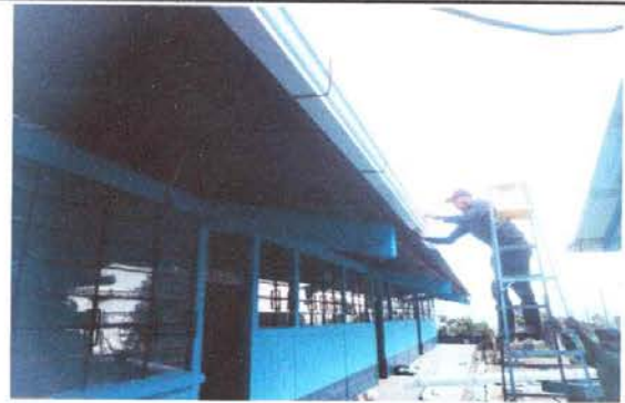
Foto 20: Sustitución de canal de pvc
