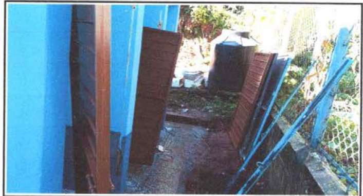
Foto 22: Sustitución de puerta en servicios sanitarios
