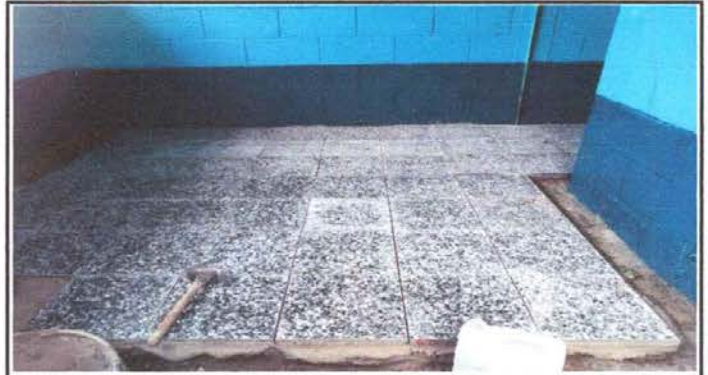
Foto 10: Sustitución de piso de torta de concreto por piso granito
