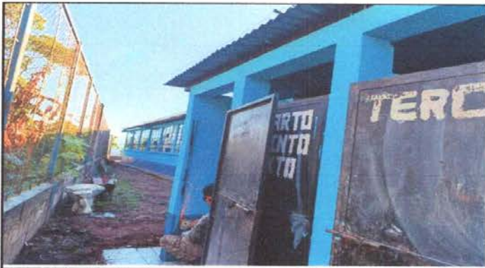
Foto 21: Sustitución de puerta en servicios sanitarios
