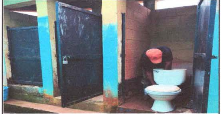
Foto 8: Sustitución de inodoro
