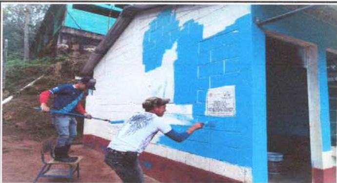
Foto 15: Pintura en muros exteriores e interiores
