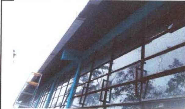
Foto 19: Sustitución de canal de pvc
