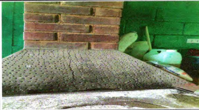
Foto 1: Sustrucción de estufa rural (Completa) incluye chimenea y planca de metal
