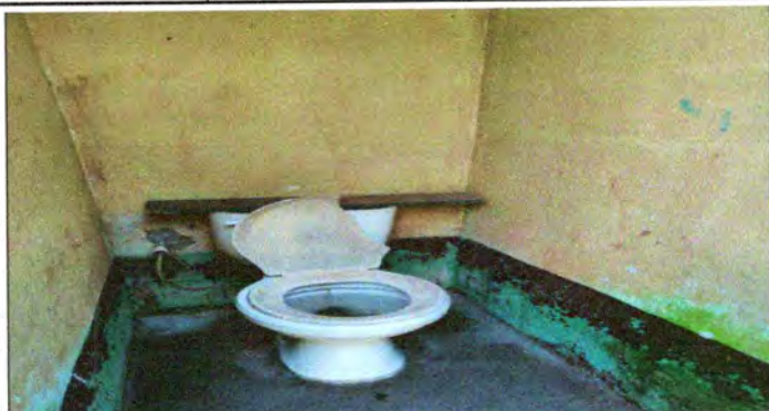
Foto 7: Sustitución de inodoro
