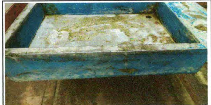
Foto 6: Sustrucción de pila de cemento de 2 lavadores
