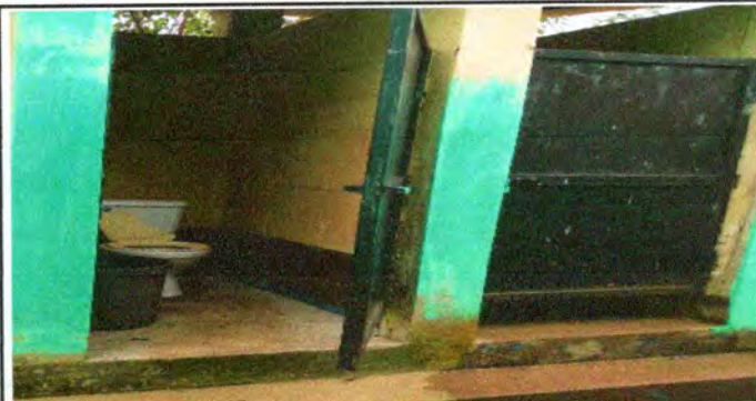
Foto 8. Sustitución de inodoro
