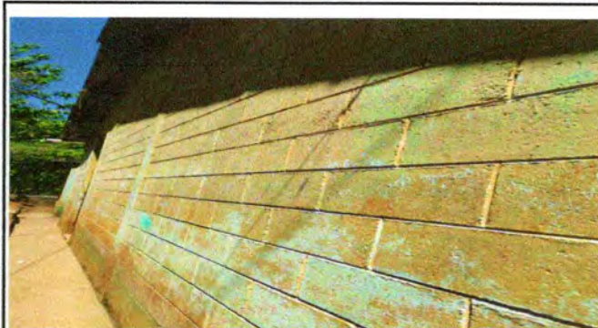
Foto 16: Pintura en muros exteriores e interiores
