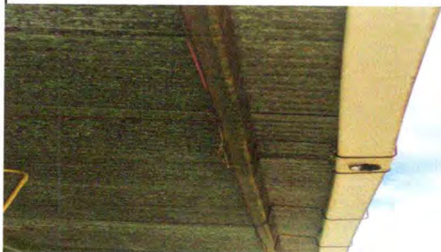
Foto 19: Sustitución de canal de pvc
