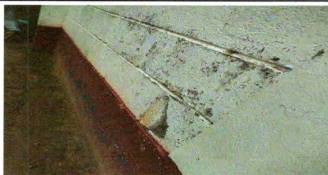
Foto 15: Pintura en muros exteriores e interiores
