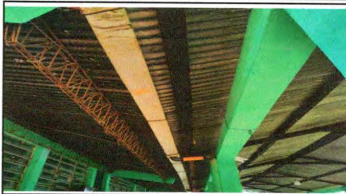
Foto 20: Sustitución de canal de pvc
