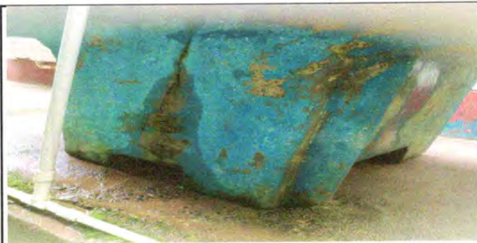
Foto 5: Sustrucción de pila de cemento de 2 lavadores
