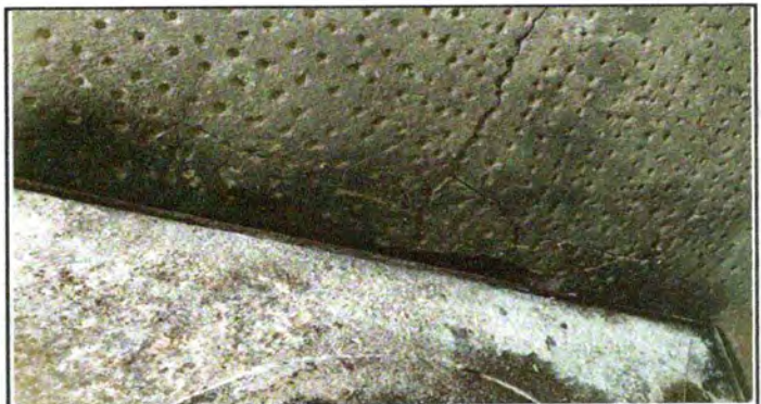
Foto 4: Instalación de azulejo en estufa rural
