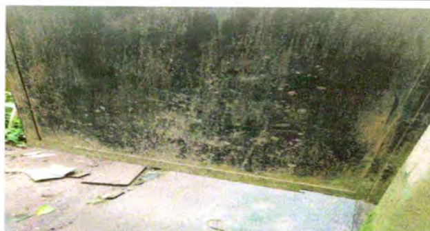
Foto 22: Sustitución de puerta en servicios sanitarios
