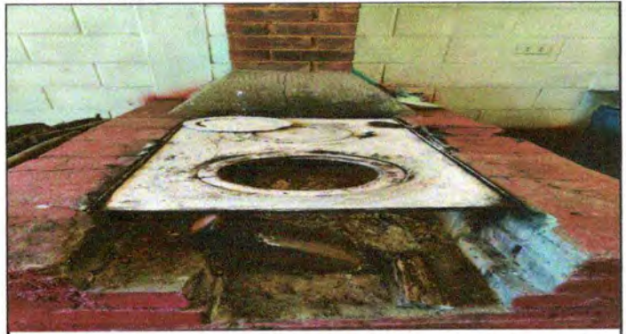
Foto 2: Sustrucción de estufa rural (Completa) incluye chimenea y planca de metal
