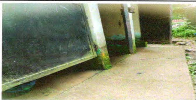
Foto 21: Sustitución de puerta en servicios sanitarios
