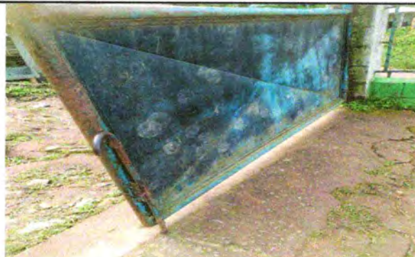
Foto 14: Mantenimiento a portones de metal
