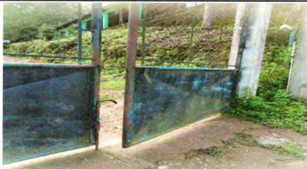
Foto 13: Mantenimiento a portones de metal
