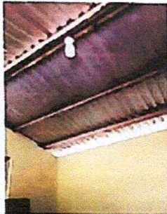
FOTO 9: Reparación de cableado eléctrico
