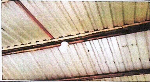
FOTO 7: Reparación de cableado eléctrico
