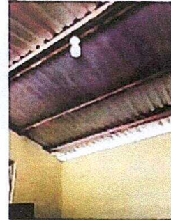
FOTO 8: Reparación de cableado eléctrico
