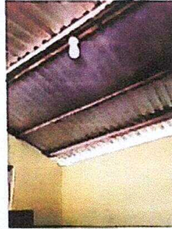
FOTO 8: Reparación de cableado eléctrico
