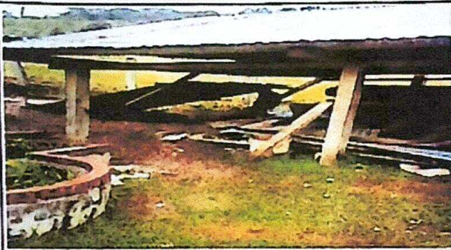
Foto 1: Sustrucción de inodoros
