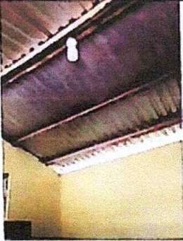
FOTO 7: Reparación de cableado eléctrico
