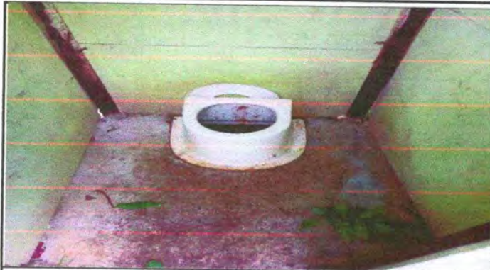
Foto 1: Sustrucción de inodoros
