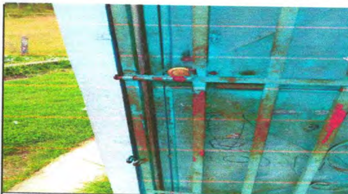
Foto 4: Sustrucción de puertas en aulas de 2.2m*95cm
