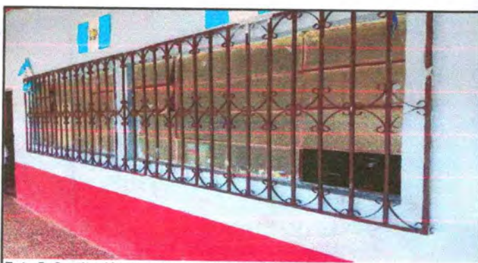
Foto 5: Sustrucción de balcones en aula (3.5m * 1m)
