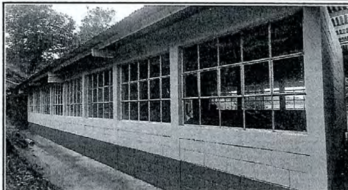
Foto 13: Sustitución de Pintura exterior de las aulas
