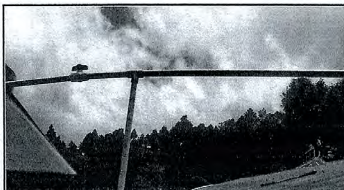
Foto 15: Sustitución de Tubería de pvc
