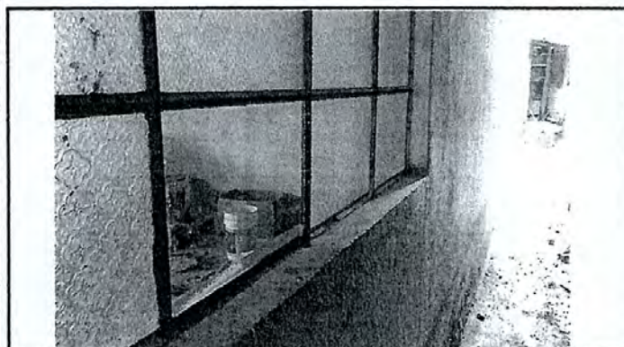
Foto 3: Sustitución de vidrios de ventanas
