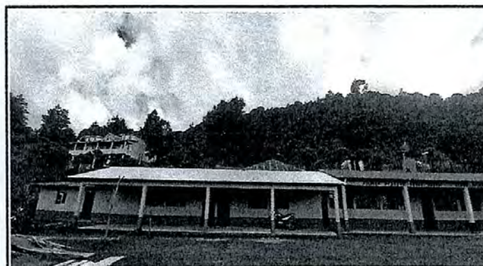
Foto 16. Sustitución de pintura del exterior de aulas
