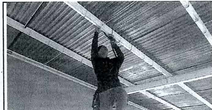
Foto 12: sustitución de cableado y reparación de tubo flexible
