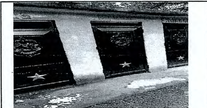
Foto 6: Sustitución de Puertas de Baño
