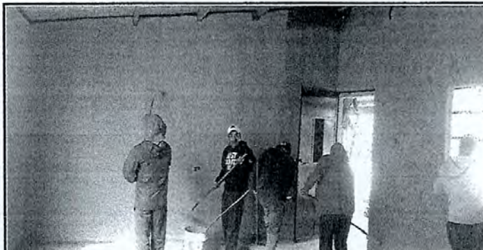
Foto 18: sustitución de pintura de interior de aulas
