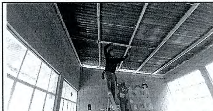
Foto 10. Sustitución de Lámparas por Flaponeras
