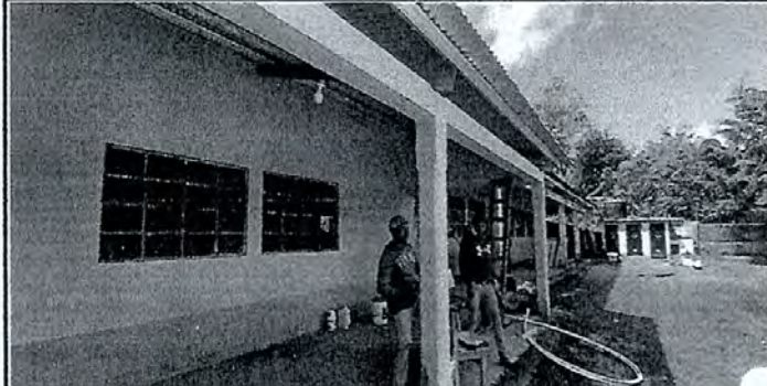
Foto 16. Sustitución de pintura del exterior de aulas
