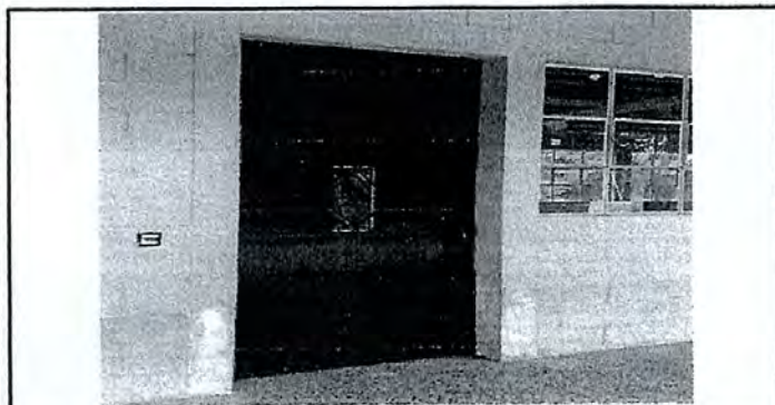
Foto 5: Mantenimiento a puertas de aulas
