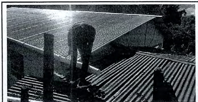
Foto 17: Sustitución de canal de pvc
