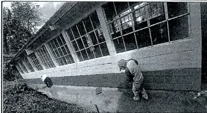
Foto 13: Sustitución de Pintura exterior de las aulas
