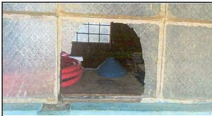
Foto 3: Sustitución de vidrios de ventanas
