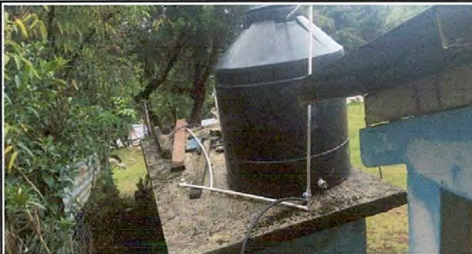
Foto 15: Sustitución de Tuberí de pvc
