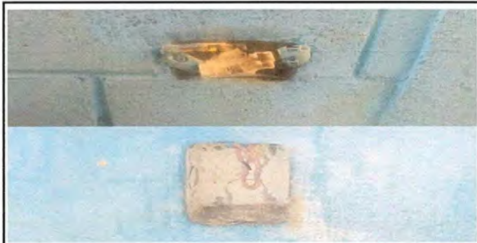
Foto 11: Sustitución de toma Corriente y Apagadores
