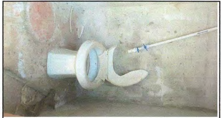
Foto 2: Sustitución de inodoros
