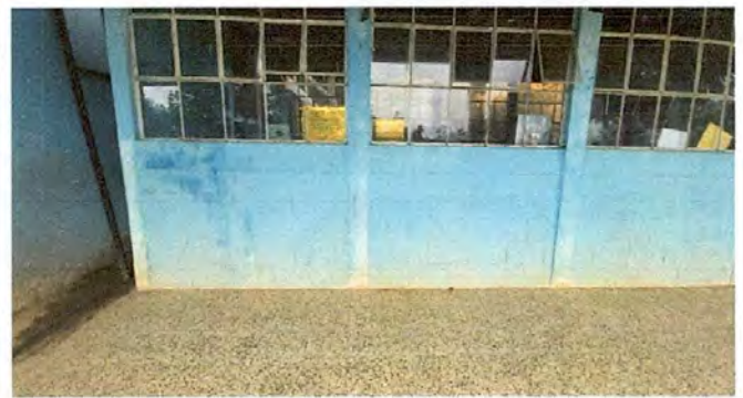
Foto 16. Sustitución de pintura del exterior de aulas
