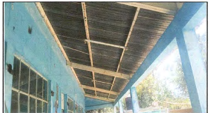
Foto 10: Sustitución de Lámparas por Flaponeras
