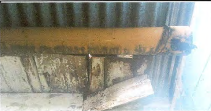
Foto 17: Sustitución de canal de pvc
