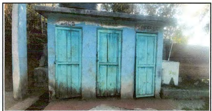
Foto 6: Sustitución de Puertas de Baño
