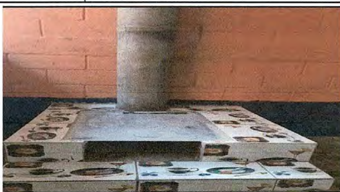
Foto 8: Remodelación de estufa artesanal y cambio de planchas con chimenea. N0. 1
