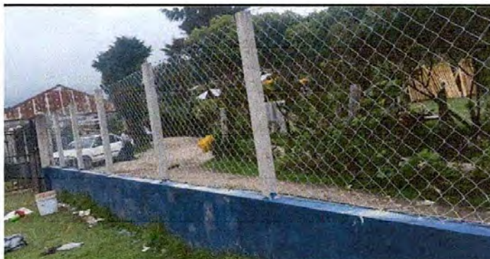
Foto 5: Reparación de circulación de malla Galvanizada
