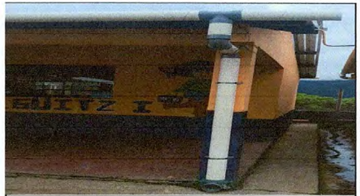
Foto 4: SUSTITUCIÓN DE CANALES DE AGUA PLUVIAL
