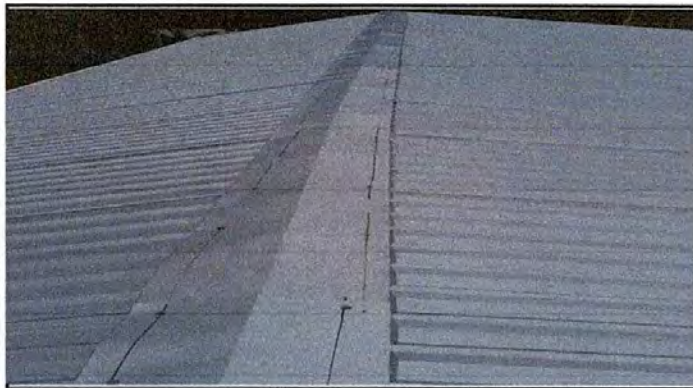
Foto 3: Sustrución de lámina de aulas preprimaria 2o. Y 5o. Por lámina troquelada.
