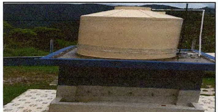
Foto 6: Sustrución de depósito de agua de 2,500LT
