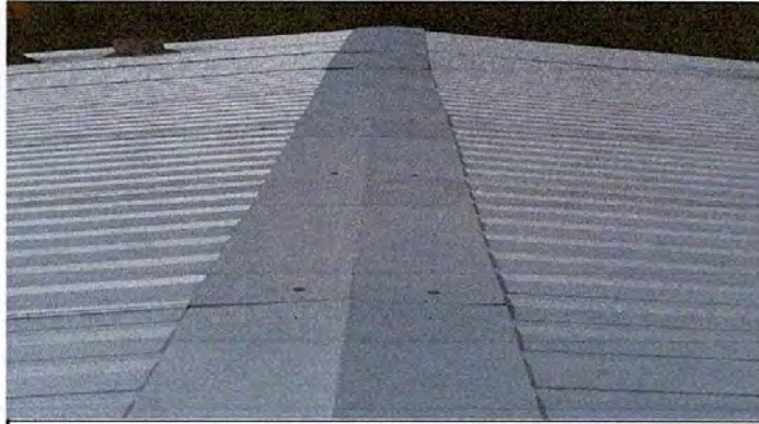
Foto1: Sustrución de lamina de cocina por lámina troquelada
