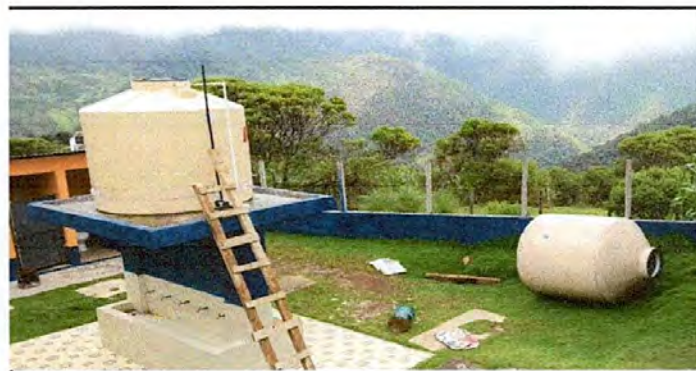
Foto 6: Sustitución de depósito de agua de 2,500LT
