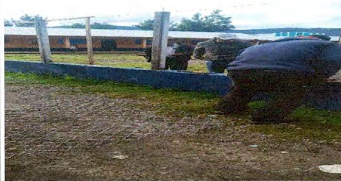
Foto 5: Reparación de circulación de malla Galvanizada
