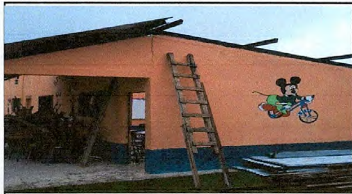
Foto 7: Sustrucción de costaneras pequeñas de madera por metal.
