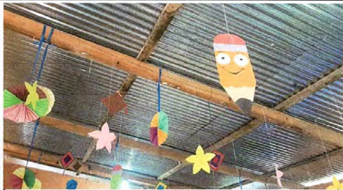
Foto7: Sustitución de costaneras pequeñas de madera por metal.
