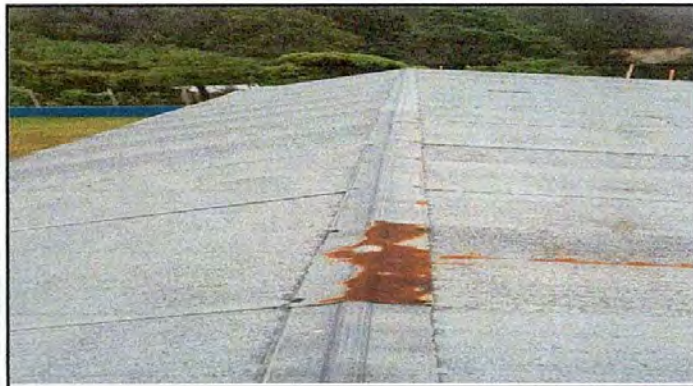
Foto 3: Sustitución de lámina de aulas preprimaria 2o. Y 5o. Por lámina troquelada.
