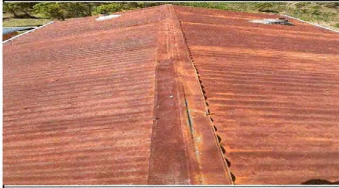
Foto 1: Sustitución de lamina de cocina por lámina troquelada
