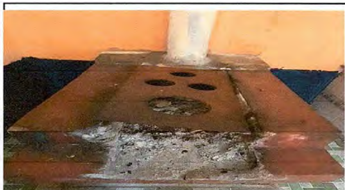
Foto 9: Remodelación de estufa artesanal y cambio de planchas con chimenea. N0. 2
