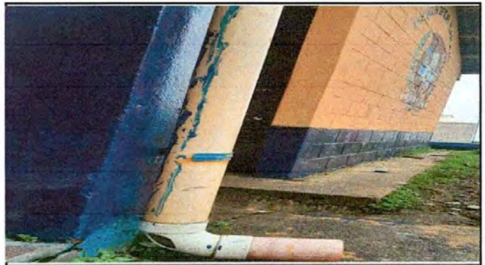
Foto 4: SUSTITUCIÓN DE CANALES DE AGUA PLUVIAL
