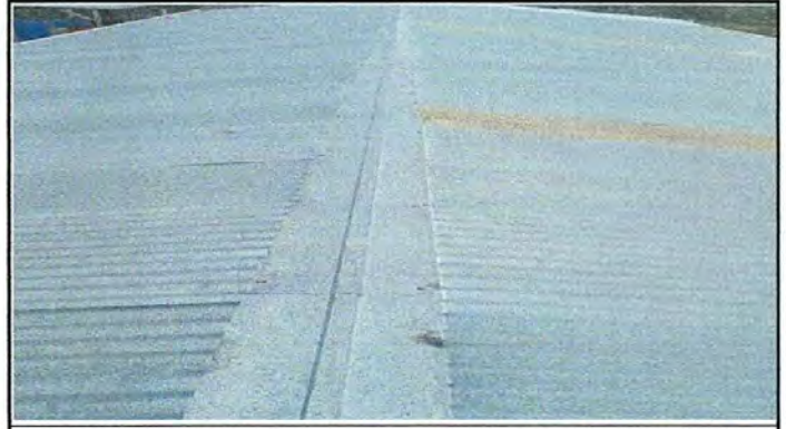
Foto 2: Sustitucion de lamina de aulas de 1o. 3o., 4o. y 6o. por lámina troquelada.
