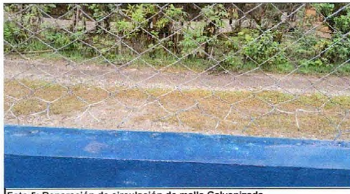
Foto 5: Reparación de circulación de malla Galvanizada
