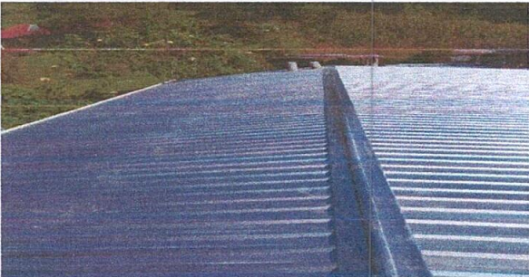
Foto1: SUSTITUCION DE LAMINA 100%
