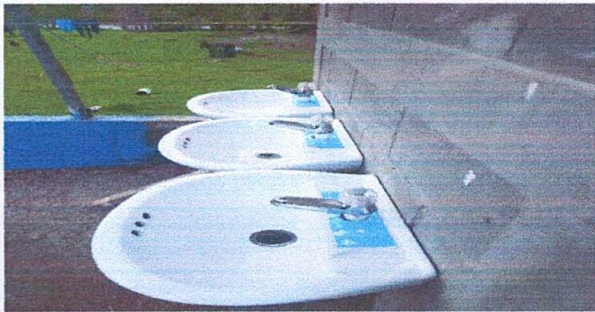
Foto 6: SUSTITUCION DE LAVAMANOS DE BAÑOS 100%
