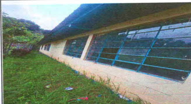
Foto 2 sustitución de soporte de metal por metal
