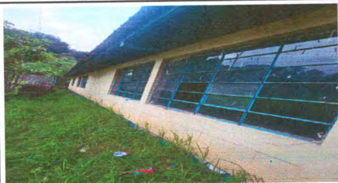
Foto 3: sustitución de estructura de soporte
