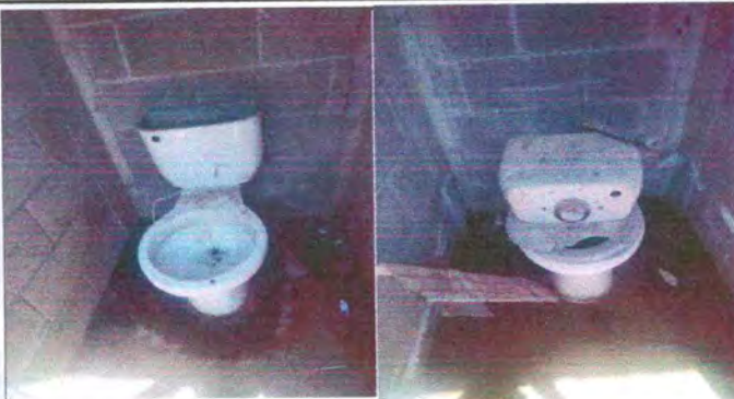
Foto 2: Sustitución de inodoros
