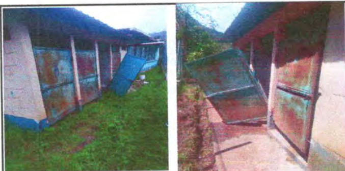
Foto 5 cambio de puertas de los baños
