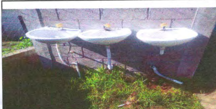
foto 6 lavamanos en servicios sanitarios susutitucion.
