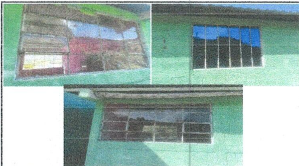
Foto 3: Mejoramiento de balcones para ventanas
