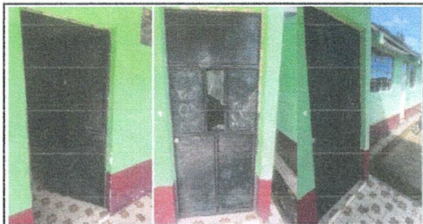
Foto 6: Mantenimiento de puertas
