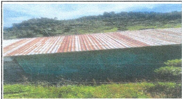
Foto 4: Cambio de Lamina en cocina
