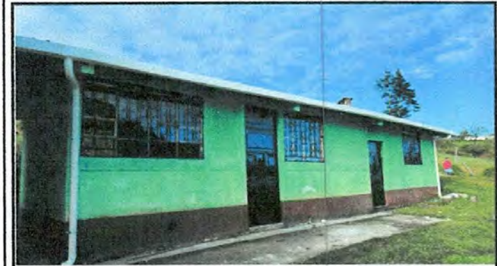
Foto1: Colocación de puertas
