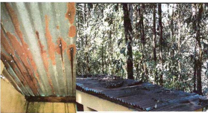
Foto 6: Laminas y reglas en malas condiciones de los baños
