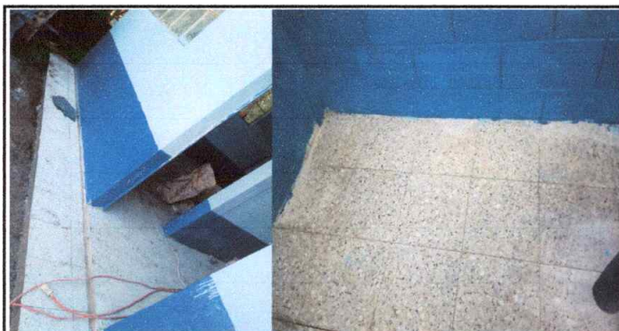
Foto 3: Instalación de piso de granitos en la cocina y baños
