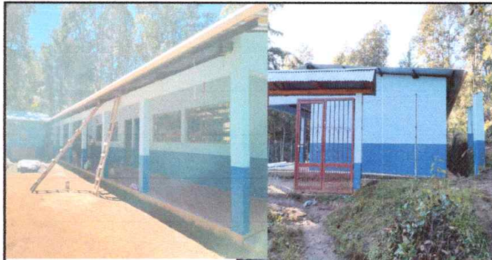
Foto 2: Aplicación de pinturas en las paredes y colocación de tubos de bajada de agua.
