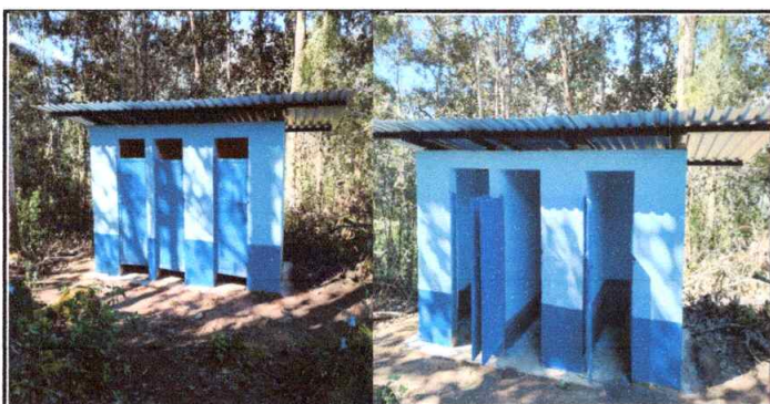
Foto 5: Tres servicios sanitarios pintados, laminas instaladas y piso granitos instalados
