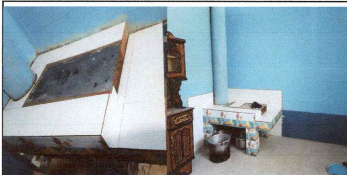
Foto1: Plancha, instalación de azulejo y chimenea terminada
