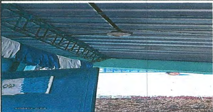
Foto 7 Sustitución de focos, pifoneras, interruptores dobles fuera dentro de cada aula
