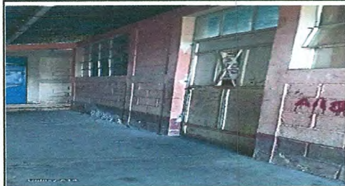
Foto 3: Sustitución de puertas con chapa de cocina
