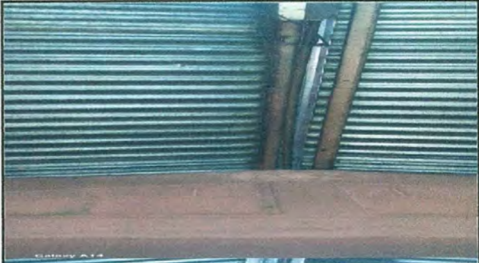
Foto 2: Sustitución de estructura de soporte de metal por metal , techo de la cocina.
