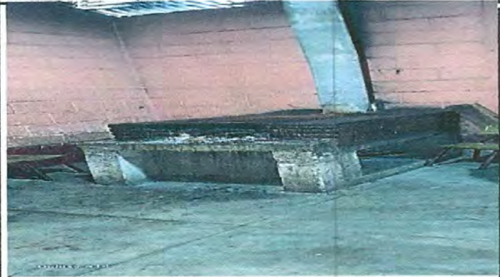
Foto 8 Reparación de cocina: Sustrucción Demoleción de estufa artesanal existente y al mismo tiempo construir una estufa ecológica, ahorrador de leña (completa), instalación de azulejo de figuras en estufa
