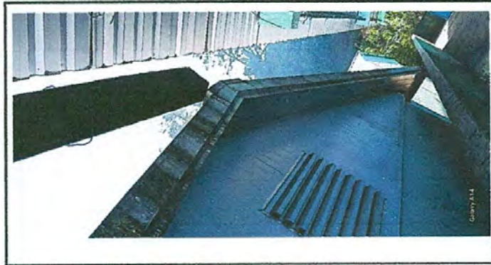
Foto 4,1 Sustitución de canal de PVC en tres aulas
