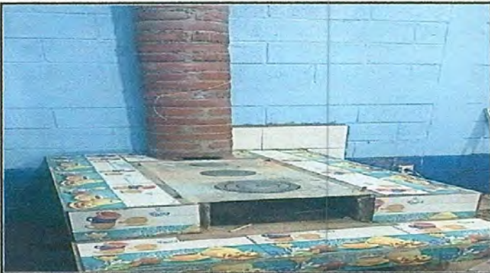
Foto 8: Finalización de la reparación de cocina: Sustitución y demolición de estufa artesanal existente y construcción de estufa ecológica, ahorrador de leña (completa), instalación de azulejo de figuras en estufa.
