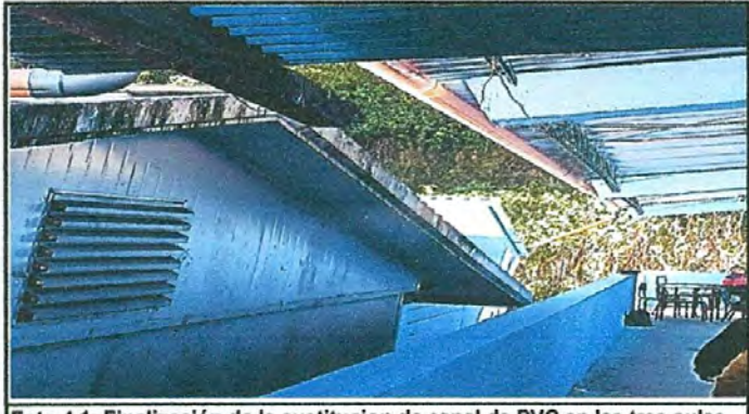
Foto 4.1: Finalización de la sustitucion de canal de PVC en las tres aulas.
