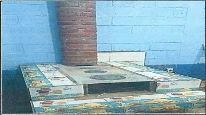
Foto 9: Finalización de mano de obra especializada, demolición de estufa rural por estufa ecologica, ahorrador de leña. (Completa) chimenea y plancha de metal.
