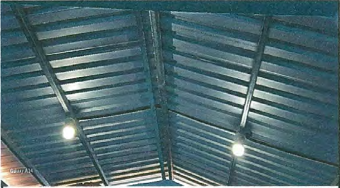
Foto 2: Terminación de la sustitucion de la estructura de soporte de metal, techo de cocina.
