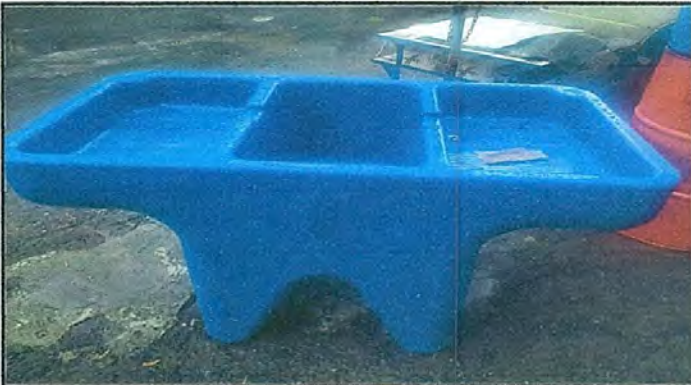
Foto 9.1: Finalización de la sustitución de pila/ lavatrasto rural. Por pila lavatrastos de plástico moderno.
