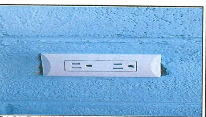
Foto 7.1: Finalización de la sustitucion de tomacorrientes en la direccion y en las 3 aulas
