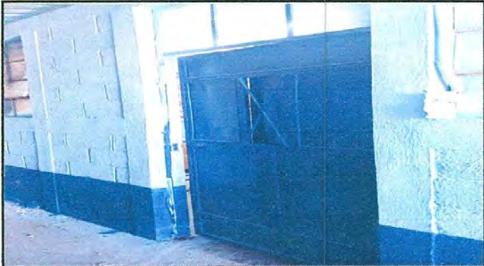
Foto 3: Finalización de la sustitucion de puerta con chapa de la cocina.
