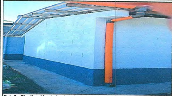
Foto5: Finalización de la pintada de la cocina, interior y exterior.
