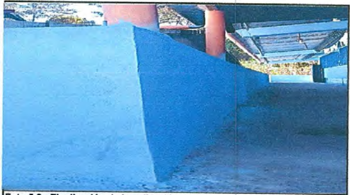
Foto 5.2: Finalización de la aplicación de pintura en el muro de contencion interior y exterior
