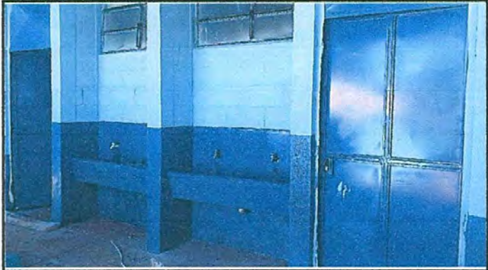
Foto 3.1: Finalización de la sustitucion de puertas de baños.
