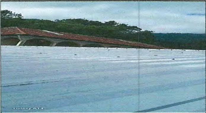
Foto1: Finalización de la sustitución del techo de la cocina.
