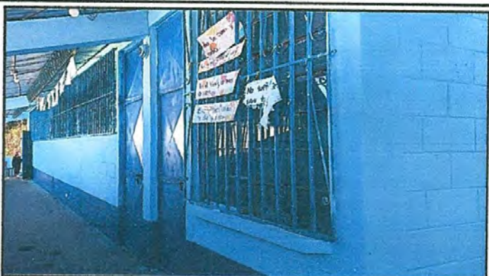
Foto 5.1: Finalización dela pintada en las tres aulas interior y exterior.
