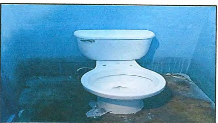
Foto 6: Finalización de la sustitucion de inodoro con su accesorios.
