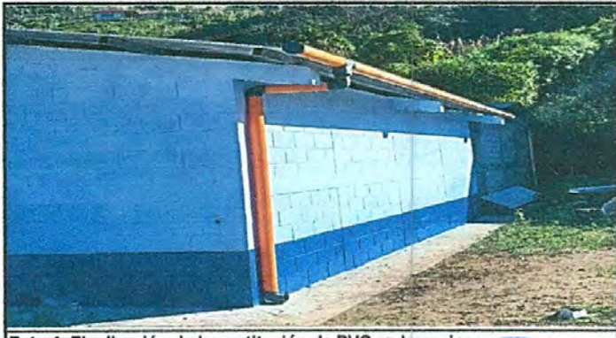
Foto 4: Finalización de la sustitución de PVC en la cocina.
