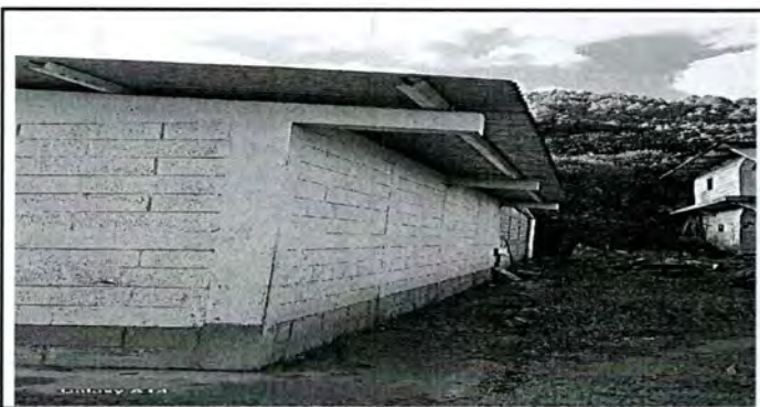
Foto 4: Sustitución de canal de PVC en cocina.
