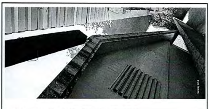
Foto 4,1 Sustitución de canal de PVC en tres aulas
