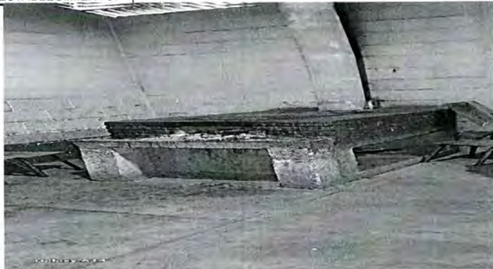
Foto 8 Reparación de cocina: Sustrucción Demolición de estufa artesanal existente y al mismo tiempo construir una estufa ecológica, ahorrador de leña (completa), instalación de azulejo de figuras en estufa
