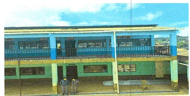
Foto 5: Techo aulas 2 y 3
