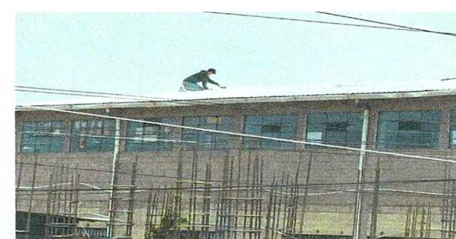
Foto 6: Techo aulas 2 y 3
