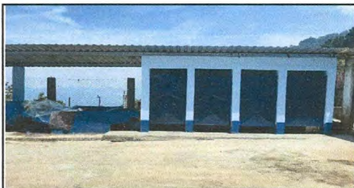
Foto 6: Finalización del entechado
