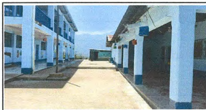
Foto 6: Finalización del remozamiento de las puertas
