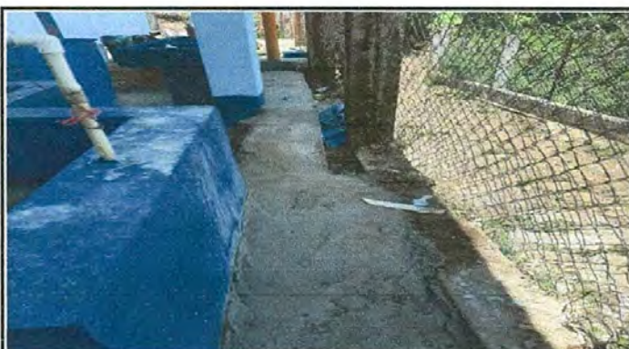
Foto 3: Culminación del drenaje
