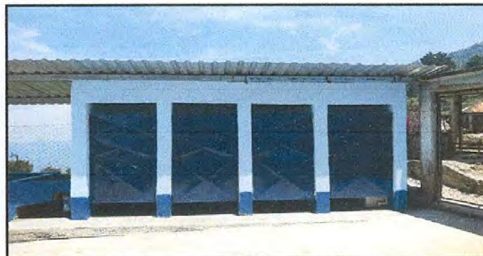
Foto 6: Finalización del remozamiento de las puertas
