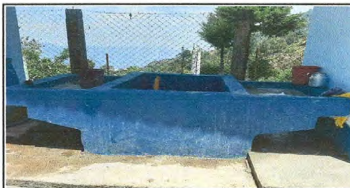
Foto 6: Finalización del remozamiento de la pila
