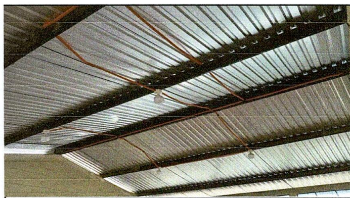
Foco 4: Sustitucion de foco por foco
