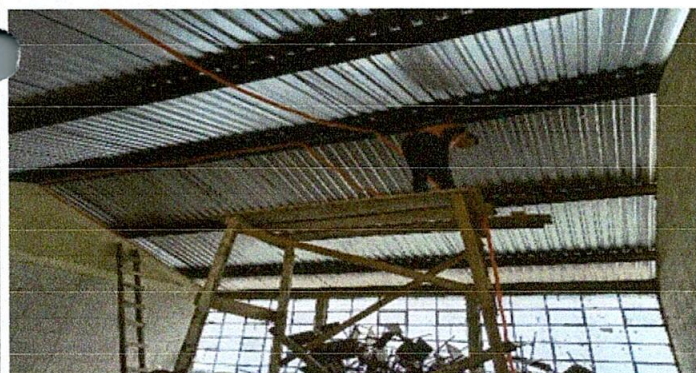
Foco 5: Sustitución de cable solido
