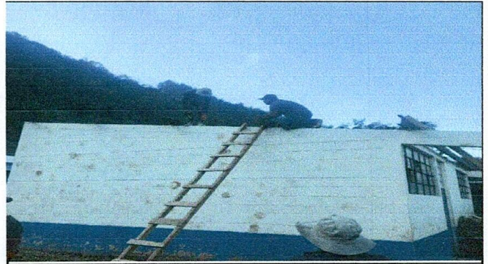
Foto 2: Sustitucion de chimenea
