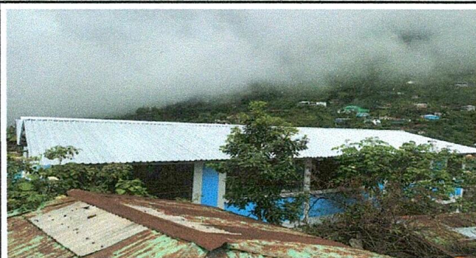
Foto 1: Sustitución de lámina por lámina troquelada aluzinc
