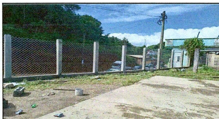
Foto 4: poste de concreto ya remodelado
