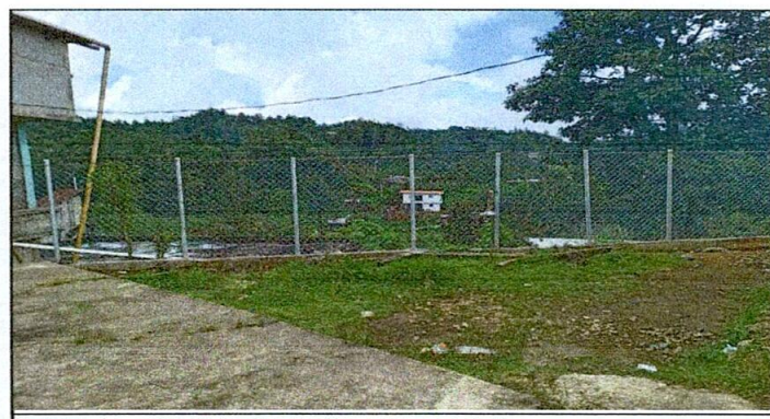
Foto 6: La malla de la circulación en buen estado
