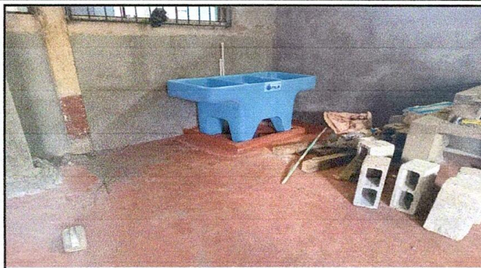
Foto 2: instalando la pila de la cocina
