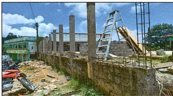
Foto 4: poste de concreto en construcción
