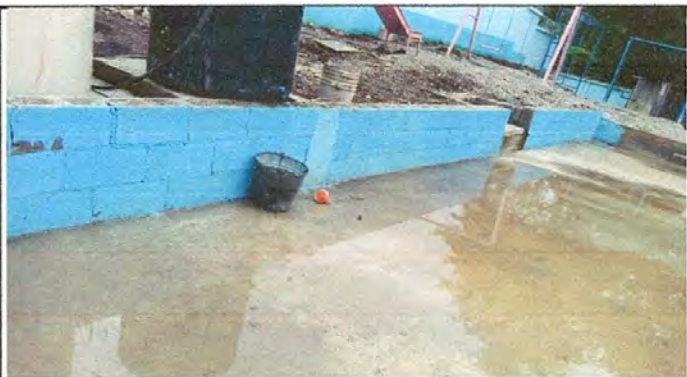
Foto 4: Muro de contención finalizada
