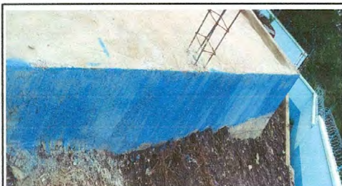
Foto 3: Muro de contención finalizada
