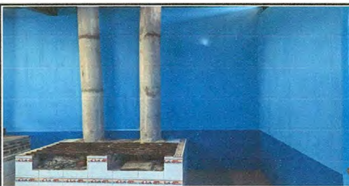
Foto 6: Instalación de chimenea finalizada
