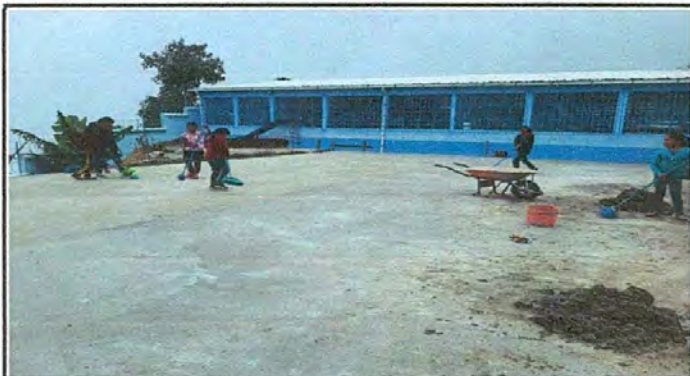
Foto 1: Finalización de losa de patio
