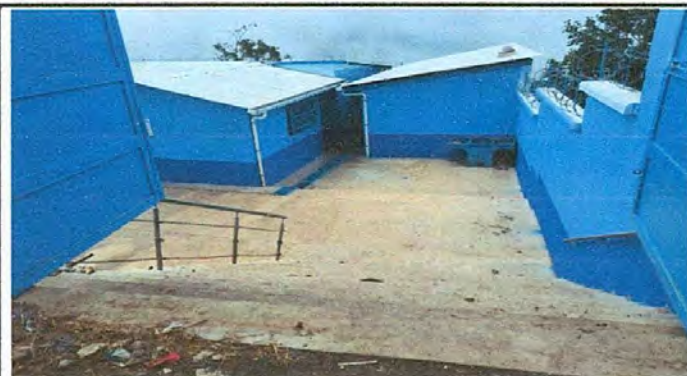
Foto 2: Pintada de muros finalizadas
