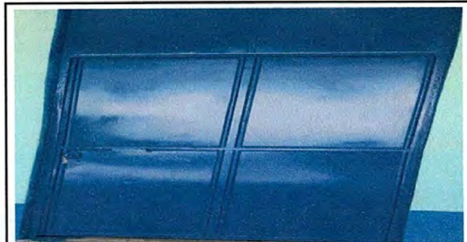
Foto 4: Mantenimiento de puertas
