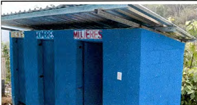
Foto 9 Sustitución de madera por estructura de soporte costanera y lamina troquelada
