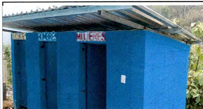
Foto 3: Sustitución de puertas
