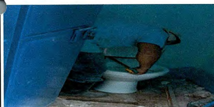
Foto 5 : Sustitución de inodoros
