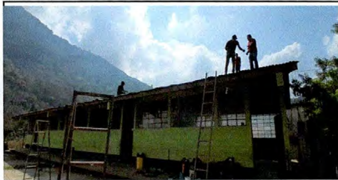
Foto 1: Sustitución de lamina por lamina
