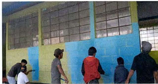
Foto 8 Pintura de muros exteriores e interiores
