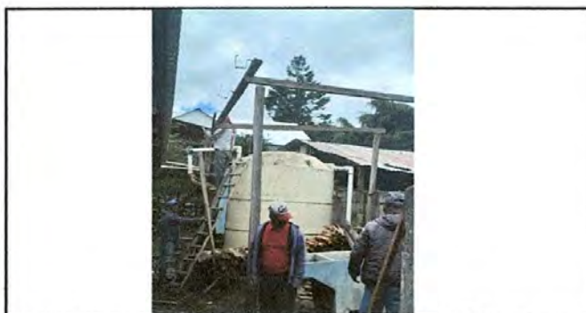
FOTO 6: SUSTITUCIÓN DE SOPORTE DE MADERA POR METAL
