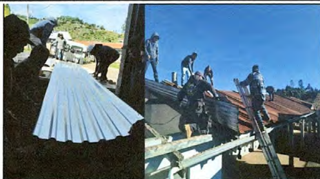
Trabajos de recepcion de material y desetechado
