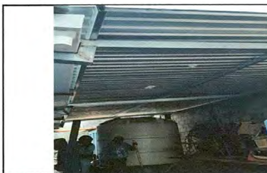
FOTO 6: SUSTITUCIÓN DE SOPORTE DE MADERA POR METAL
