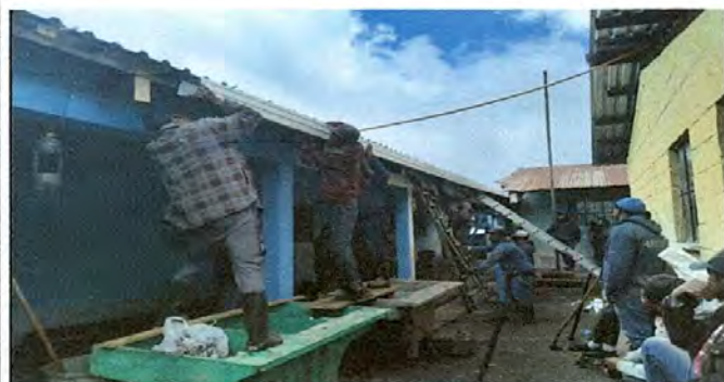
FOTO 5: SUSTITUCIÓN DE CANAL PVC
