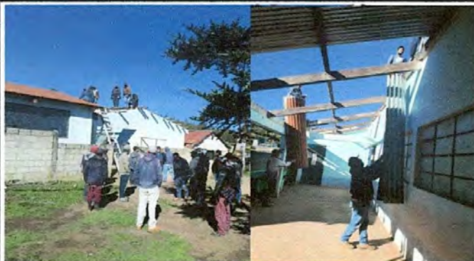
desetechado y sustitucion de láminas de Sinc
