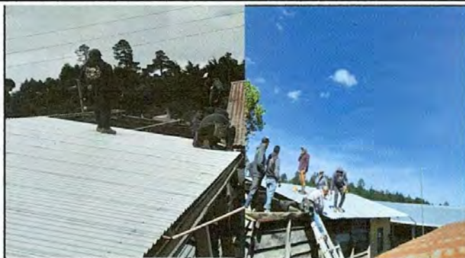
FOTO 1: SUSTITUCIÓN DE LÁMINA
