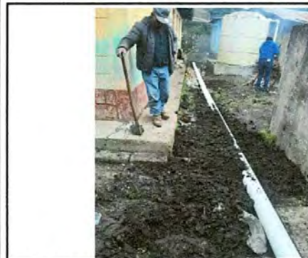
FOTO 3 SUSTITUCION DE TUBERIA LINEAL DE PVC, AGUAS NEGRAS DE 6"
