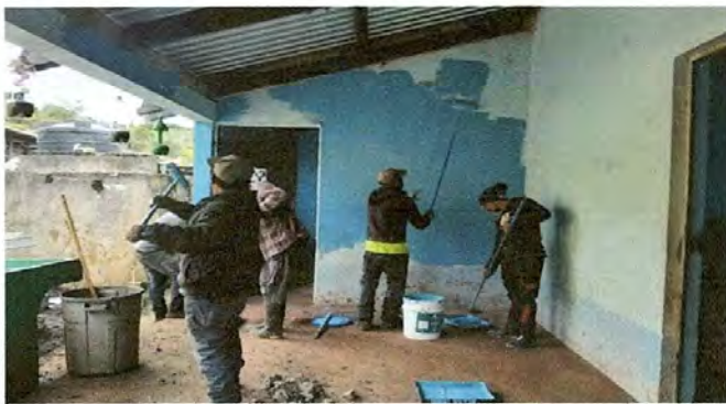
FOTO 4: PINTURA EN MUROS EXTERIORES E INTERIORES
