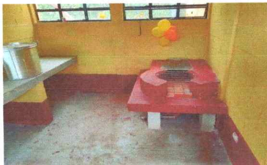
Foto 4: Estufa rural con plancha de 2 ornillas y espacio para hollas.
