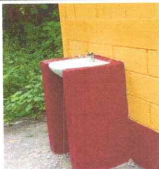
Foto 5: Una de 2 lavamanos con base de block repellido.
