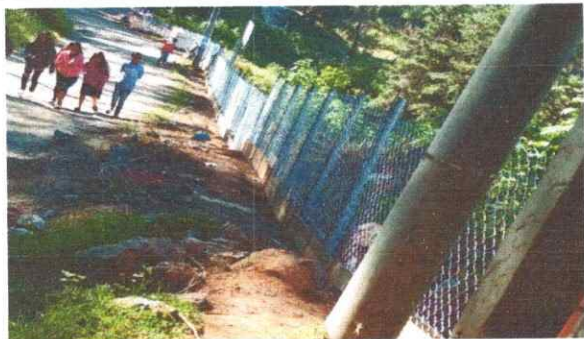
Foto 1: Muro perimetral con malla y base cimentada.
