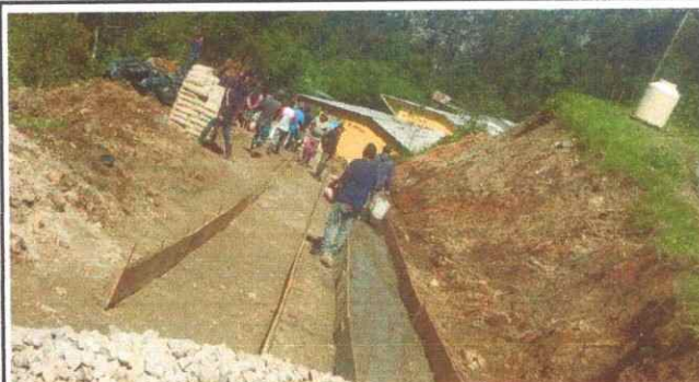
Foto 2: Preparación del espacio para la fundición de la torta de concreto.
