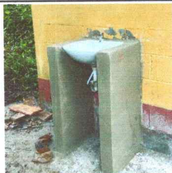
Foto 5: Instalación de lavamanos y repellado de la base del lavamanos.
