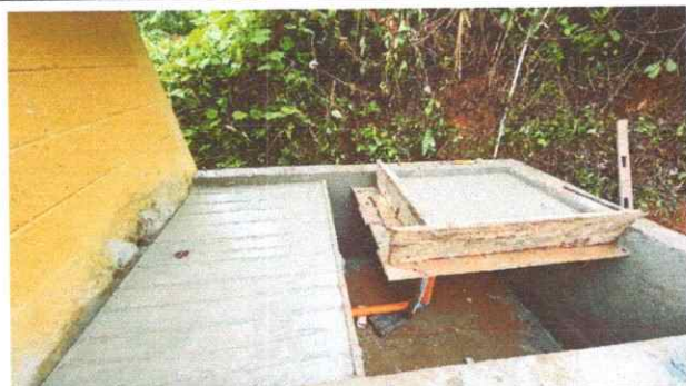
Foto 3: Fundición de lavaderos de la nueva pila.
