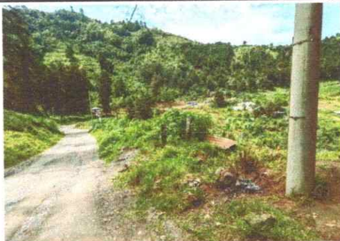
Foto 1: Limpieza y preparación del área para sembrar los postes de metal y malla para el muro perimetral.
