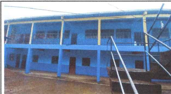
Foto 1. Pintado de la parte exterior de las instalaciones
