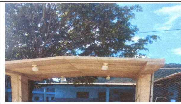
Foto 4. Colocación de Plafoneras
