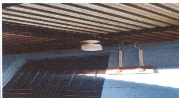
Foto 9. Instalación de focos en la parte exterior
