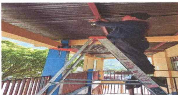
Foto 5. Cambio de plafoneras
