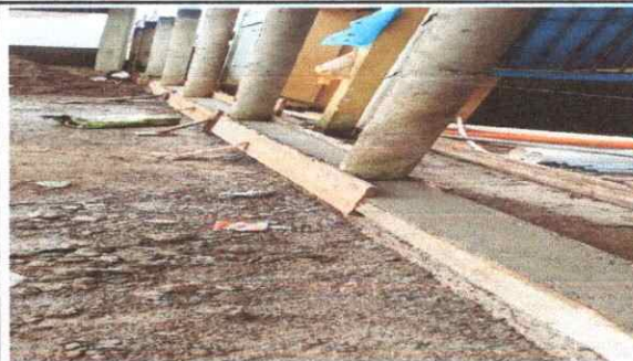
Foto 4. Reparación del muro perimetral
