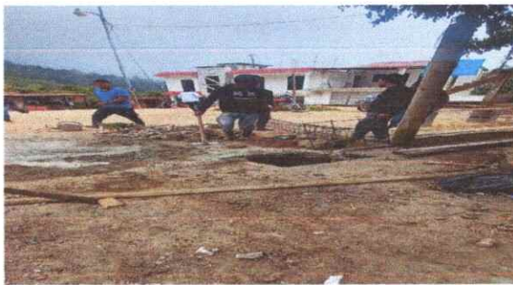
Foto 3. Colocación de zapata, para columnas del portón
