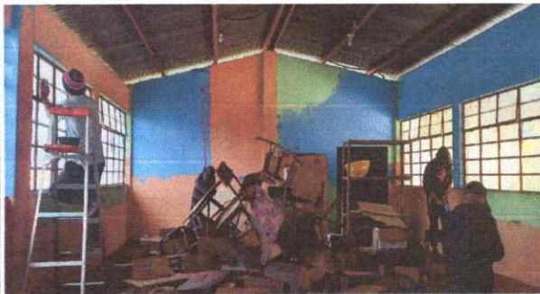
Foto 1. Pintado de aulas en la parte interior
