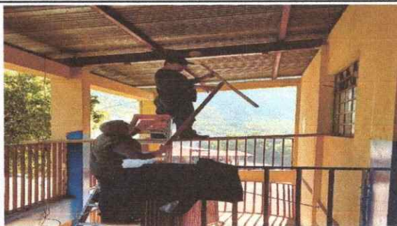
Foto 8. Sustitución de focos
